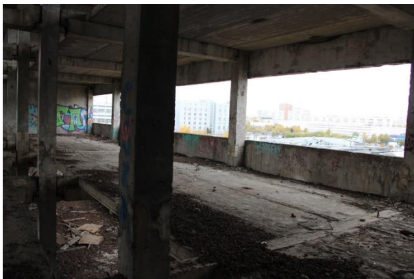
Фото 7.15. Вид на конструктивные строительные элементы объекта незавершенного строительства кадастровый № 77:05:0006005:2257, по адресу: г. Москва, Варшавское ш., д.125, корпус 3
