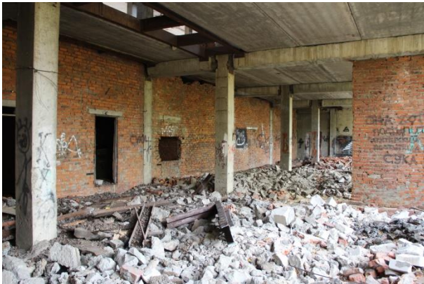
Фото 7.9. Вид на конструктивные строительные элементы объекта незавершенного строительства кадастровый № 77:05:0006005:2257, по адресу: г. Москва, Варшавское ш., д.125, корпус 3
