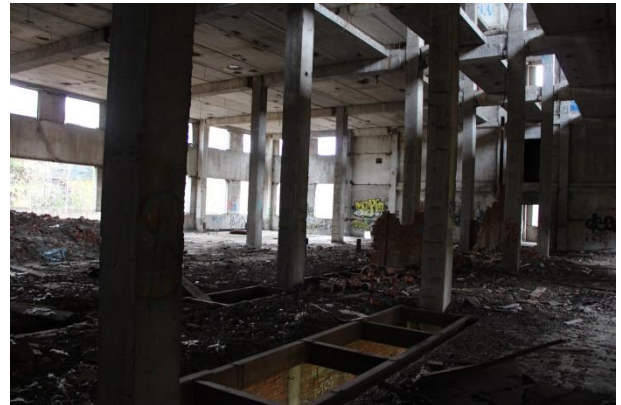
Фото 7.10. Вид на конструктивные строительные элементы объекта незавершенного строительства кадастровый № 77:05:0006005:2257, по адресу: г. Москва, Варшавское ш., д.125, корпус 3
