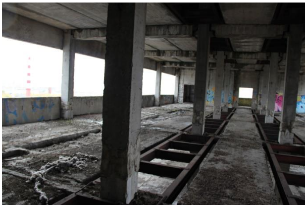
Фото 7.17. Вид на конструктивные строительные элементы объекта незавершенного строительства кадастровый № 77:05:0006005:2257, по адресу: г. Москва, Варшавское ш., д.125, корпус 3
