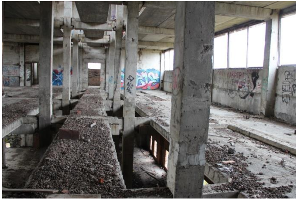
Фото 7.13 Вид на конструктивные строительные элементы объекта незавершенного строительства кадастровый № 77:05:0006005:2257, по адресу: г. Москва, Варшавское ш., д.125, корпус 3
