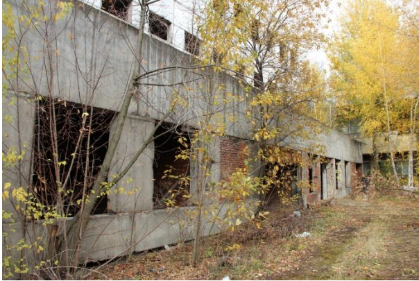
Фото 7.7. Вид на конструктивные строительные элементы объекта незавершенного строительства кадастровый № 77:05:0006005:2257, по адресу: г. Москва, Варшавское ш., д.125, корпус 3
