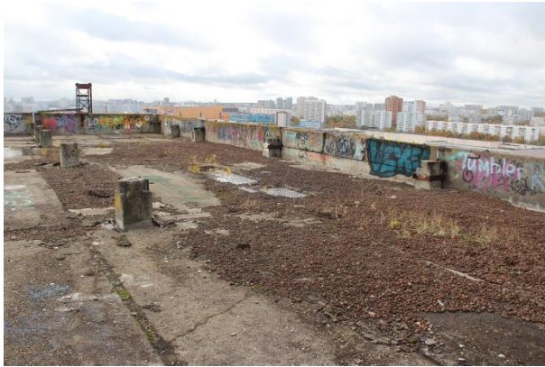
Фото 7.19. Вид на кровлю объекта незавершенного строительства кадастровый № 77:05:0006005:2257, по адресу: г. Москва, Варшавское ш., д.125, корп. 3
