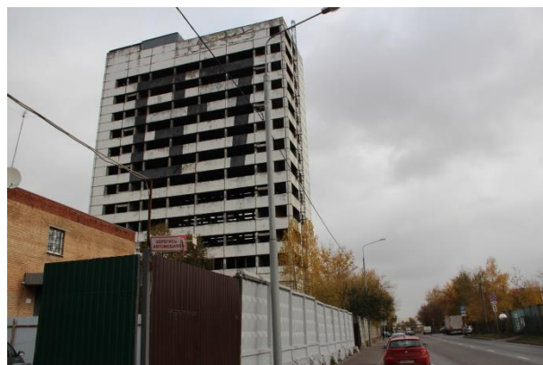
Фото 7.2 Вид на объект незавершенного строительства кадастровый № 77:05:0006005:2257, по адресу: г. Москва, Варшавское ш., д.125, корпус 3
