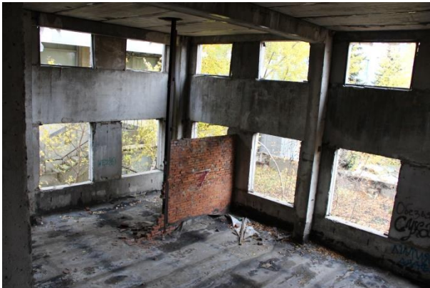
Фото 7.11. Вид на конструктивные строительные элементы объекта незавершенного строительства кадастровый № 77:05:0006005:2257, по адресу: г. Москва, Варшавское ш., д.125, корпус 3
