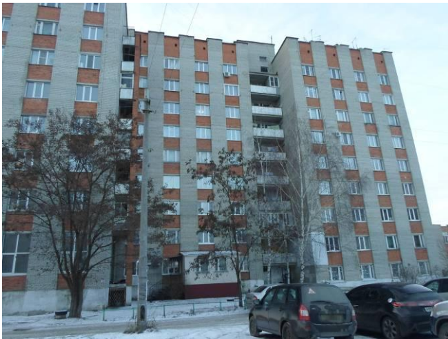
Общий вид жилого дома
