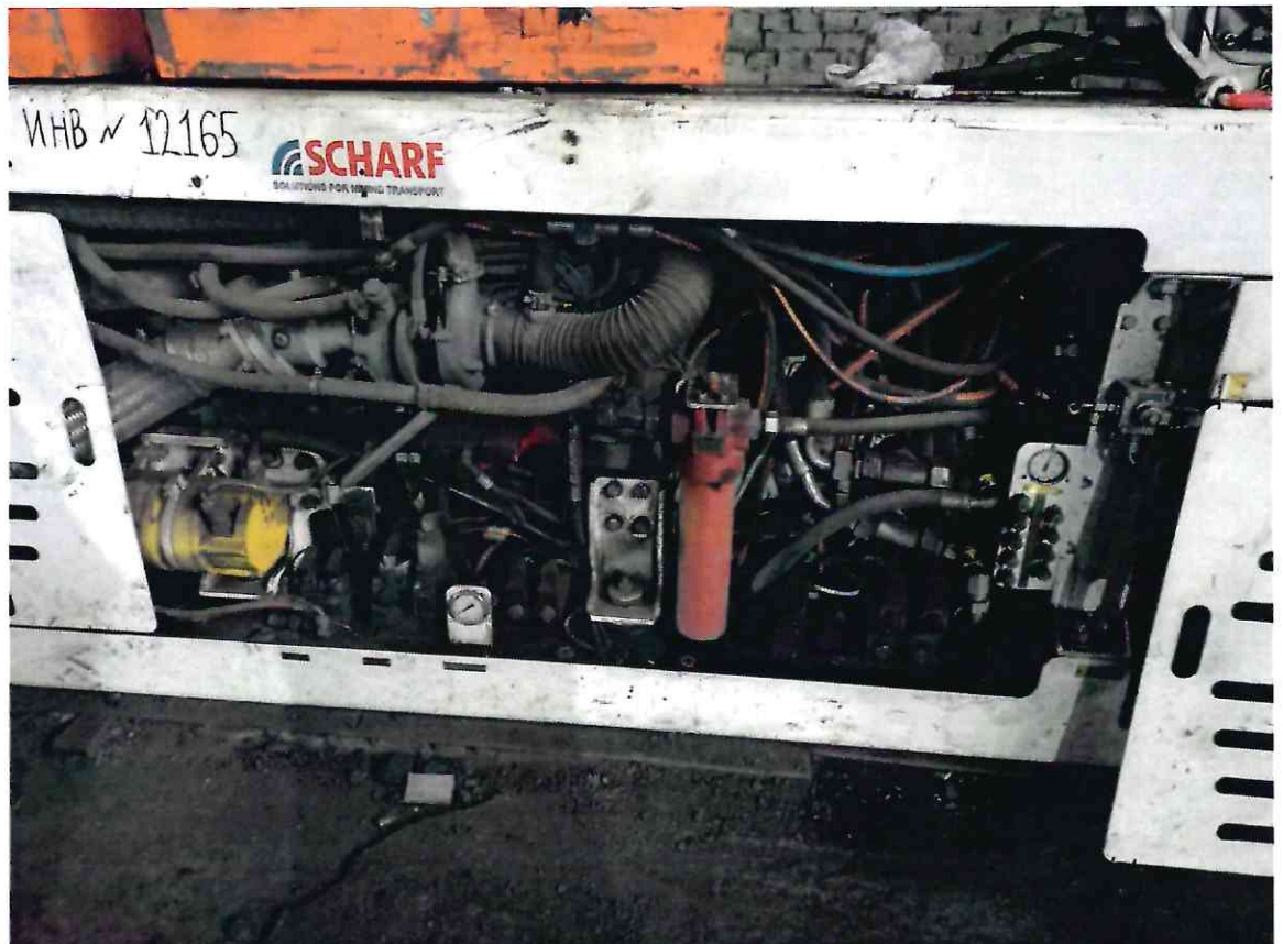
Фото 6. Дизельная секция (защитные экраны сняты)
