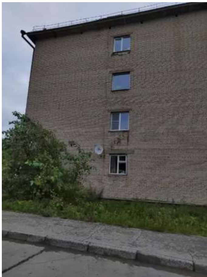
Фото №1. Общий вид дома
