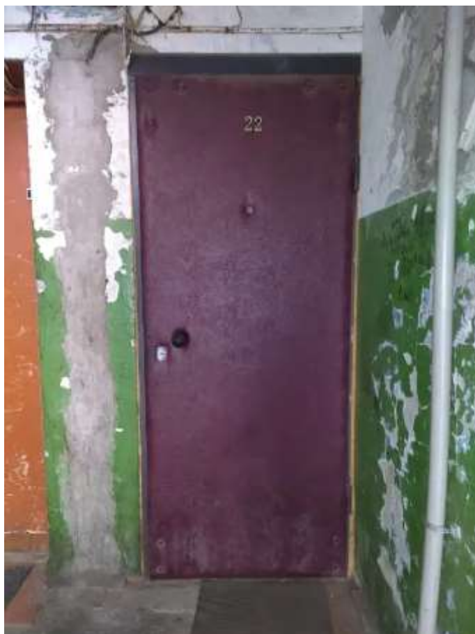
Фото №3. Входная дверь в квартиру
