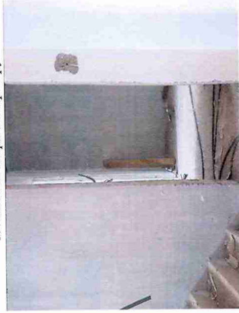
5. Входная дверь в квартиру
