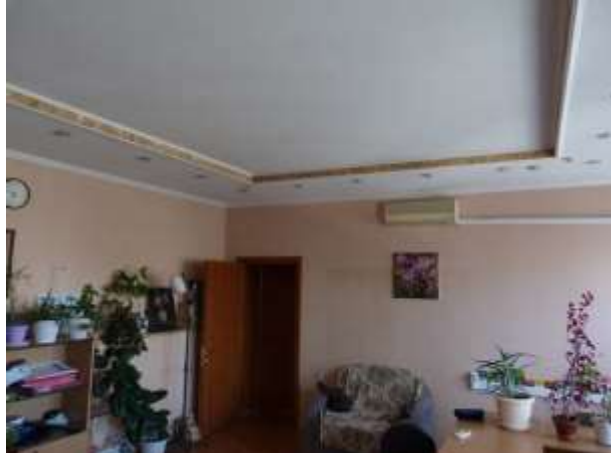
Фото 14. Состояние внутренних помещений здания
