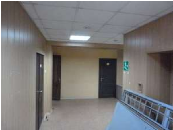
Фото 13. Состояние внутренних помещений здания
