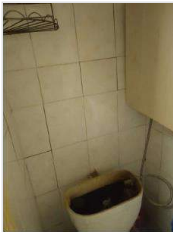
Фото 32. Туалет (помещение № 7 по плану БТИ)
