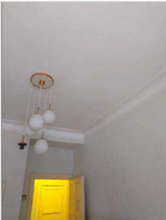
Фото 23. Жилая (помещение № 4 по плану БТИ)
