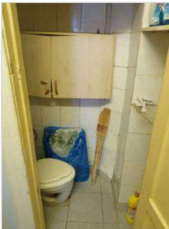
Фото 29. Туалет (помещение № 7 по плану БТИ)
