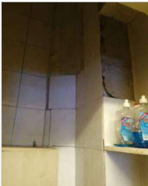
Фото 31. Туалет (помещение № 7 по плану БТИ)
