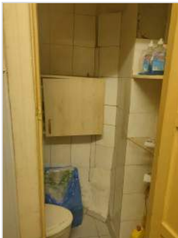
Фото 30. Туалет (помещение № 7 по плану БТИ)
