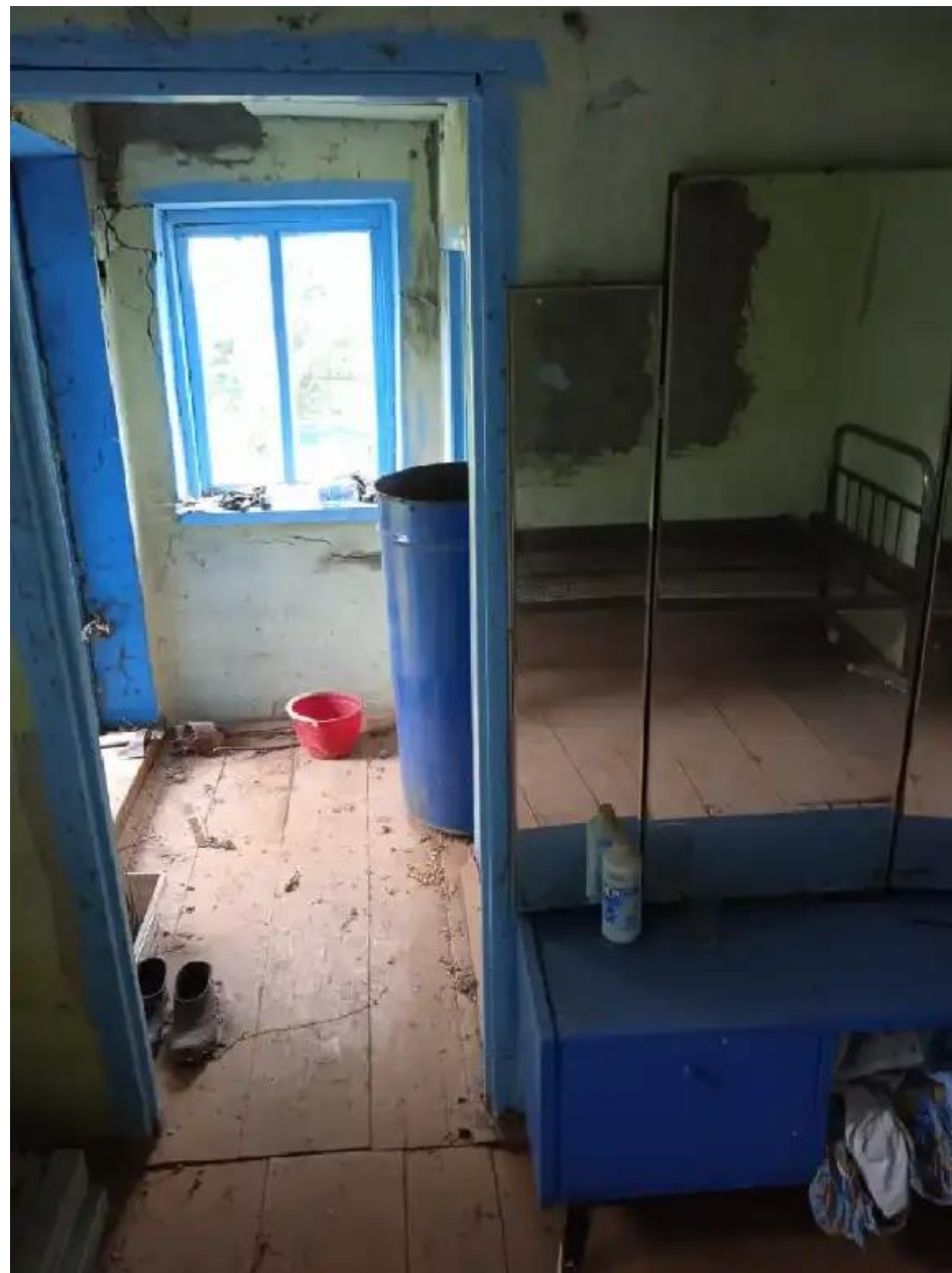
Фото №6. Общий вид участка и дома
