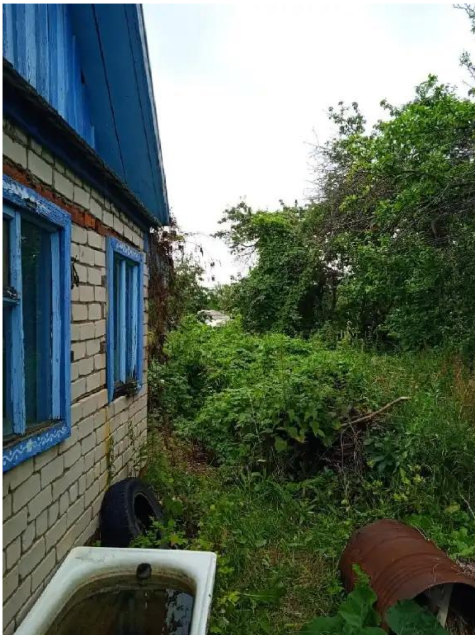
Фото №1. Общий вид участка и дома
