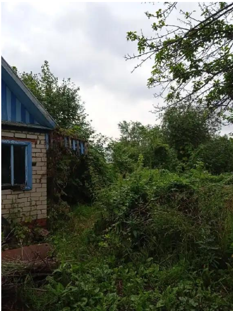
Фото №3. Общий вид участка и дома
