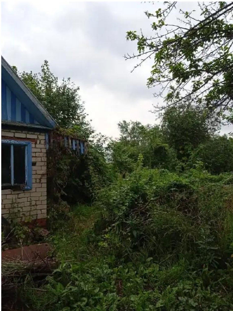
Фото №5. Общий вид участка и дома
