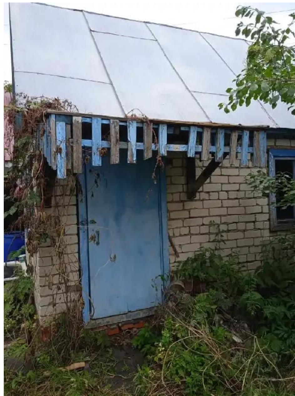
Фото №4. Общий вид участка и дома
