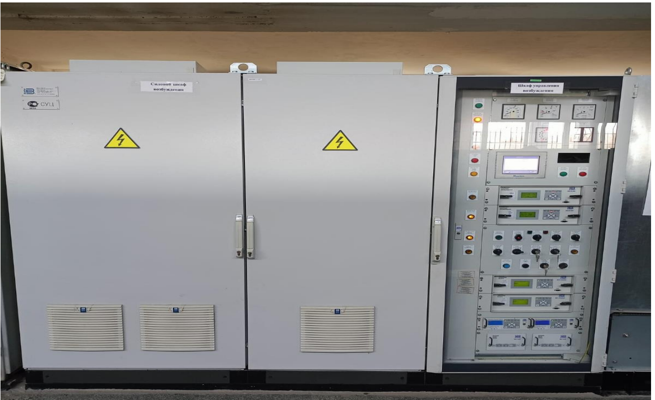
Система возбуждения тиристорная ГАЗ Малая ГЭС-3
