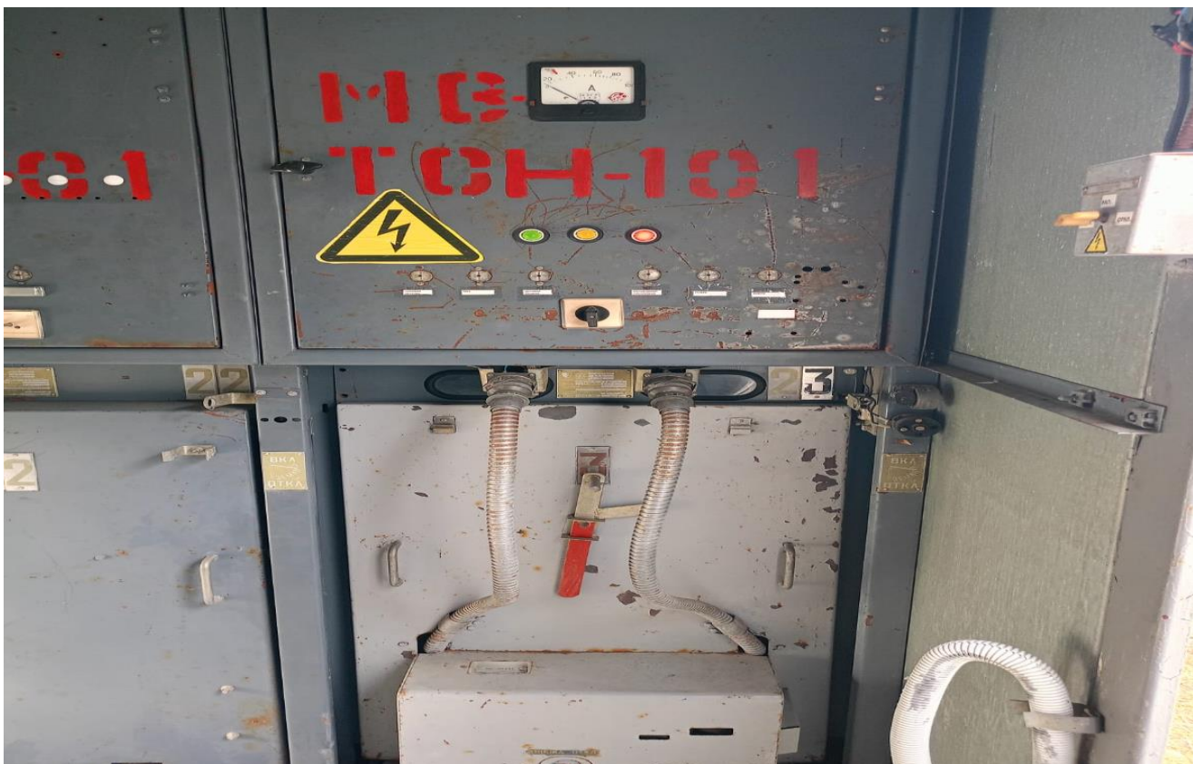
Выключатель высоковольтный маломасляный ВК10/400 ГЭС3 МВ ТСН-101
