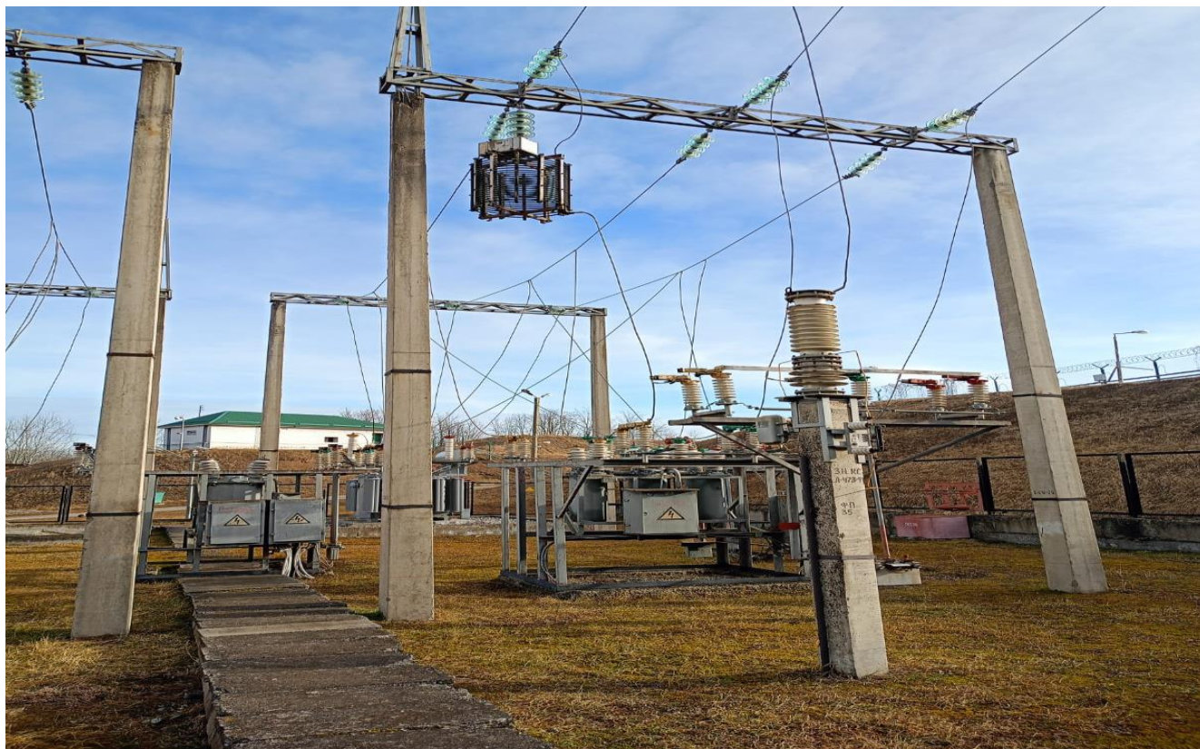
Система шин 3 1СШ-35кВ
