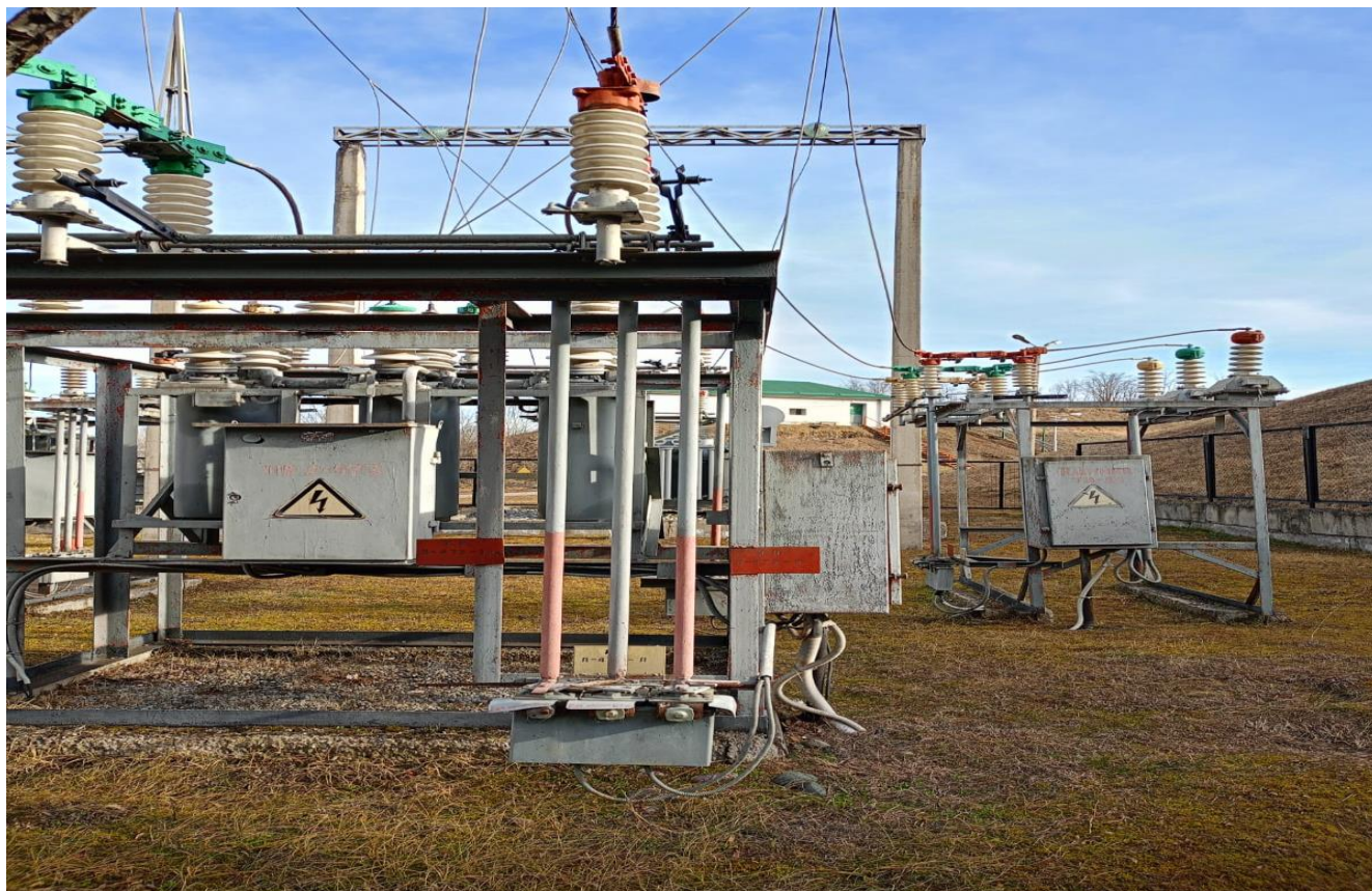
Разъединитель высоковольтный РДЗ1Б-35/630 ГЭС 3 Л-473-1
