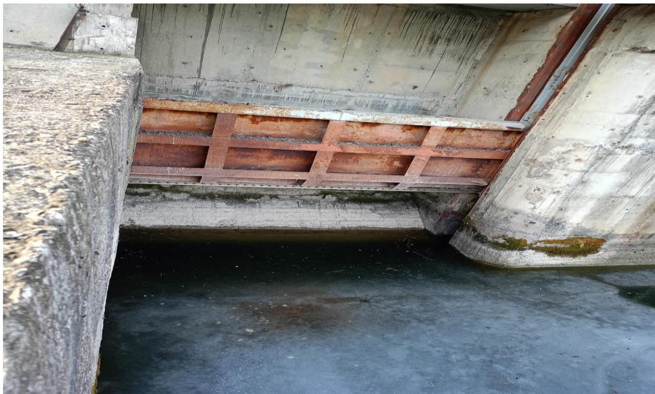
Затвор ремонтный плоский скользящий №3 НБ ГЭС-3
