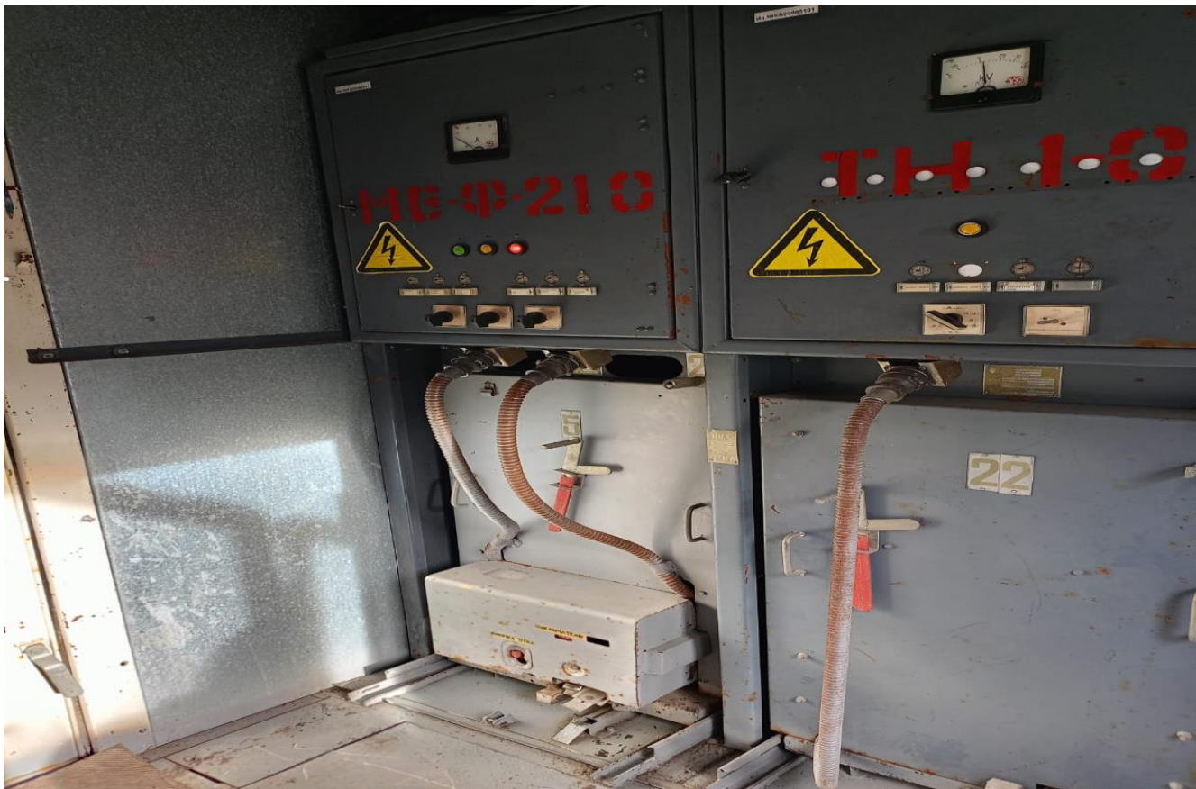
Выключатель высоковольтный маломасляный ВК10/400 ГЭС3 МВ Ф-210
