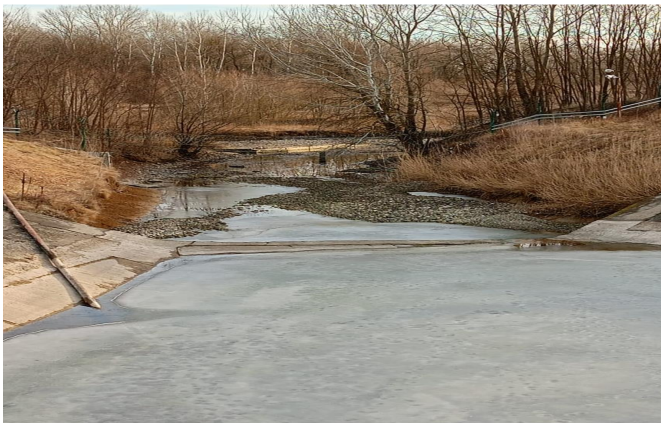
Отводящий канал ГЭС-3
