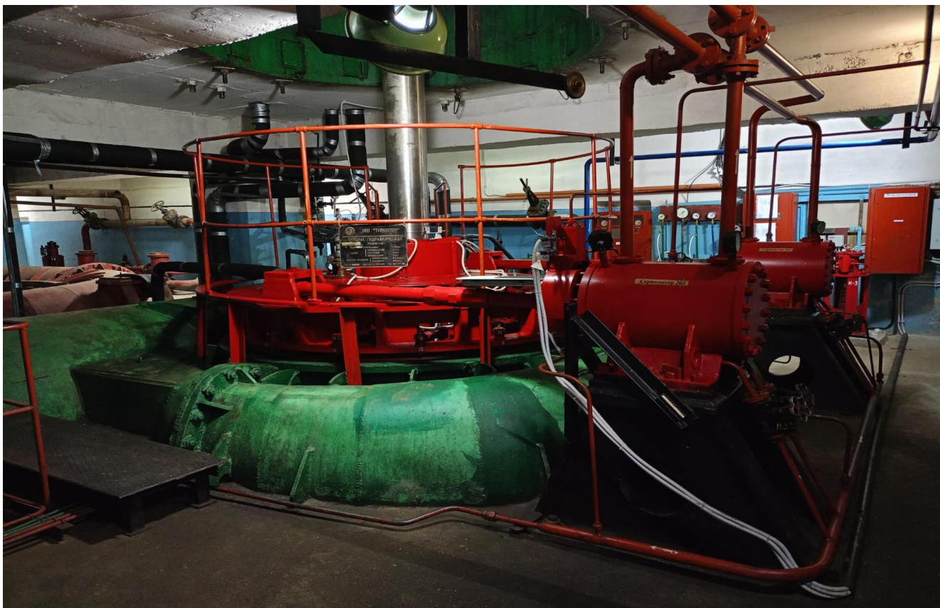
Турбина гидравлическая радиальноосевая РО-45 В 140 ГА-3 ГЭС-3
