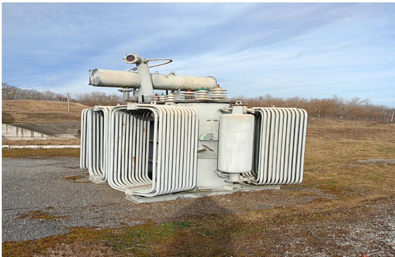
Трансформатор силовой Т-31 НГЭС
