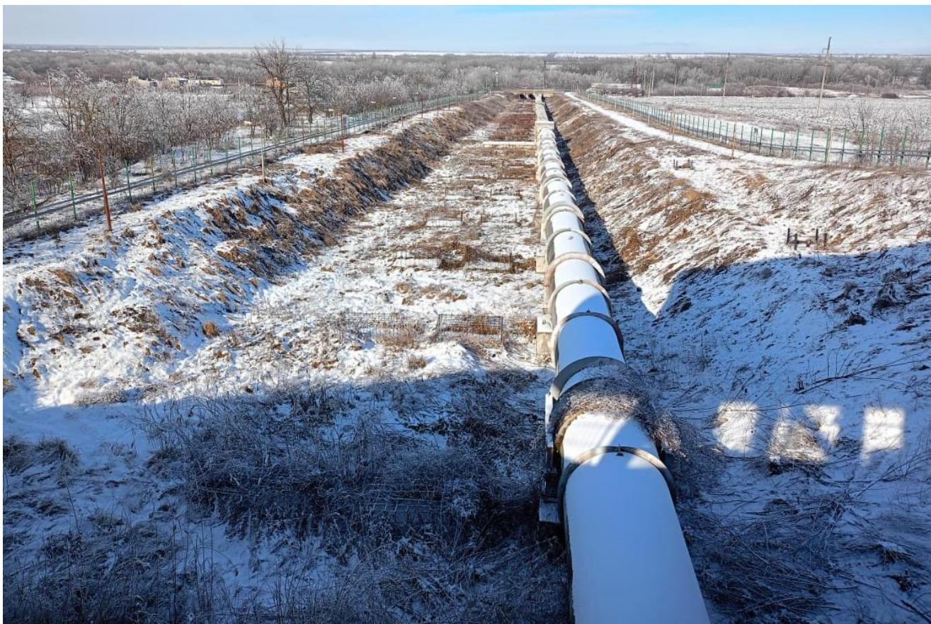
Напорный трубопровод ГЭС-3
