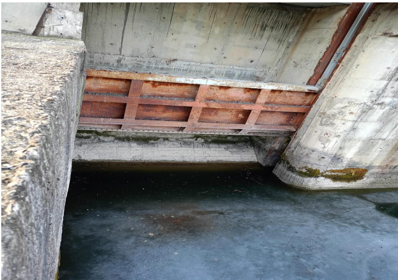
Затвор ремонтный плоский скользящий №1 НБ ГЭС-3
