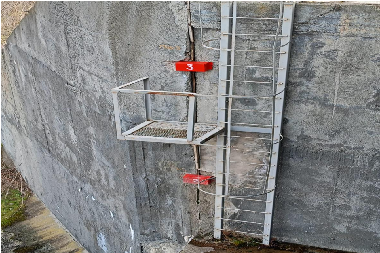
Система контрольно-измерительной аппаратуры ГЭС Малой ГЭС-3
