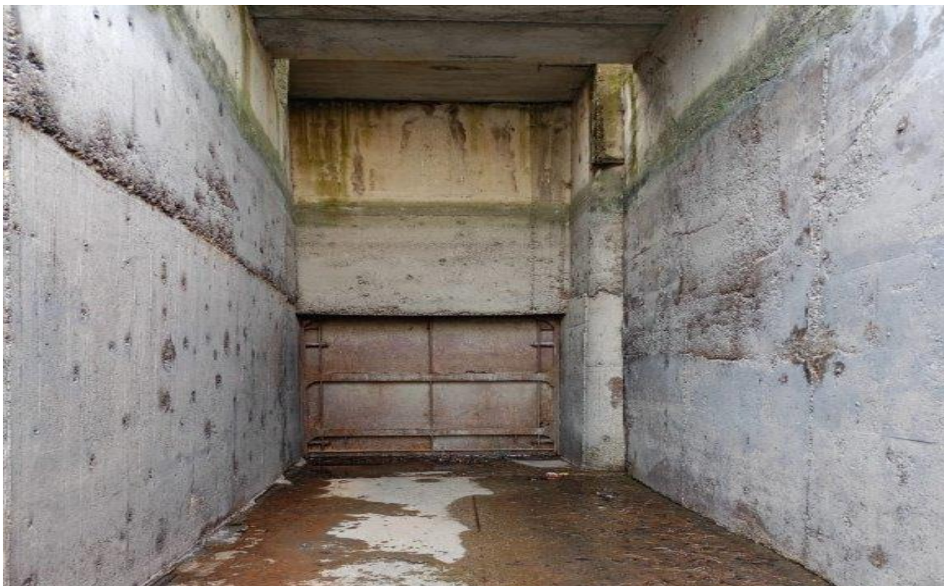
Затвор сороудерживающих сооружений плоский колесный №3 ШР ГЭС-3
