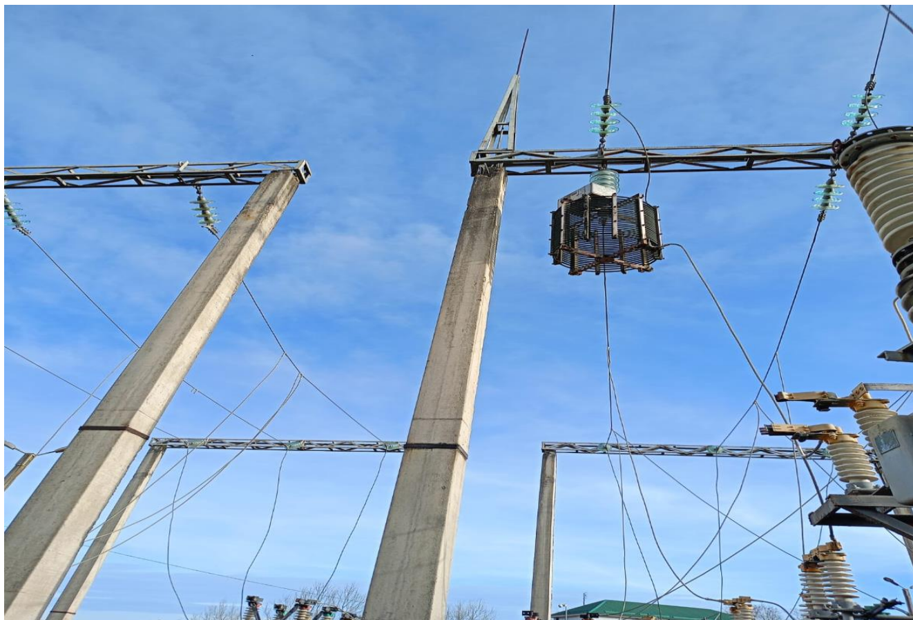
Заградитель высокочастотный ВЗ-630 ГЭС 3
