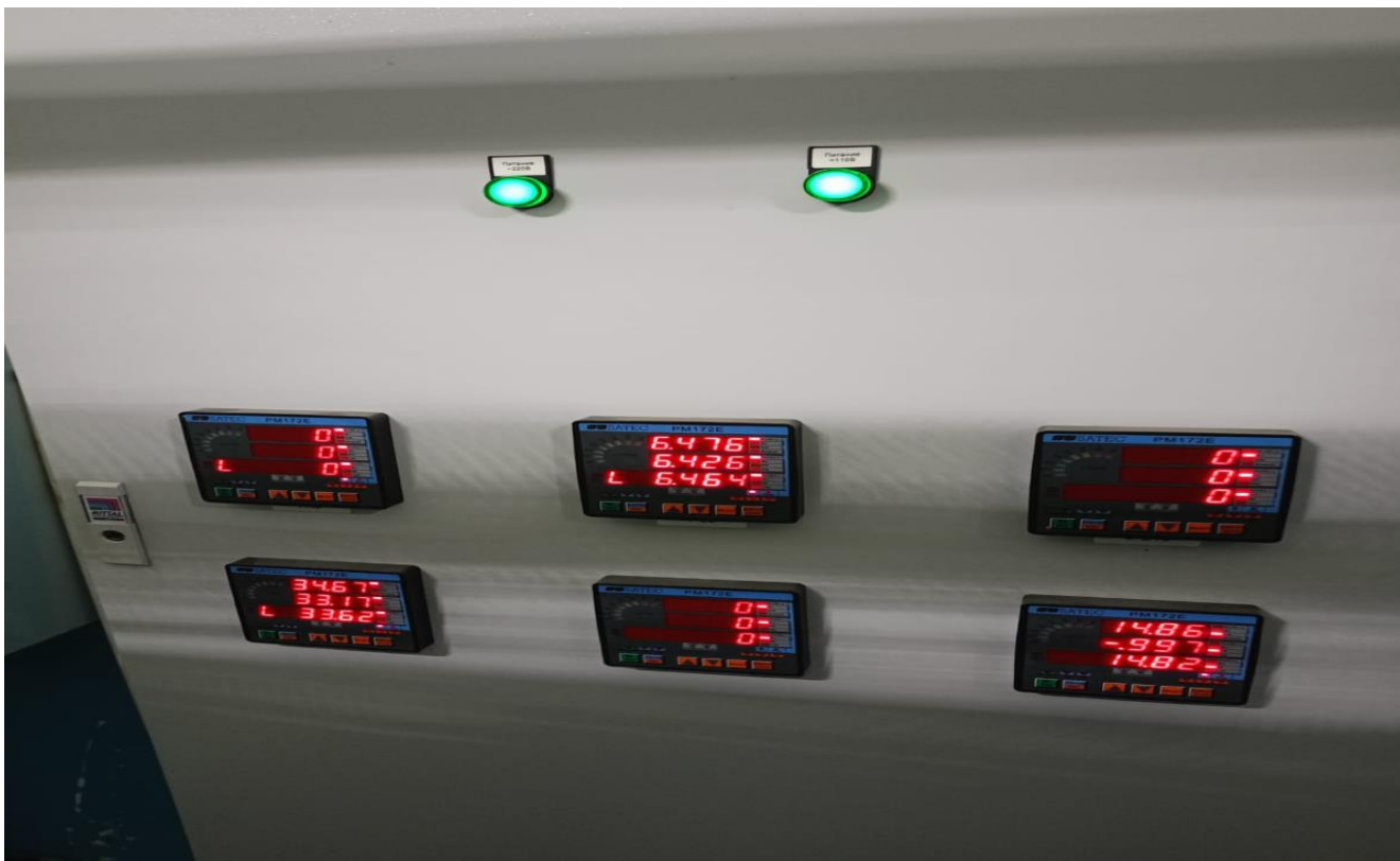
Система сбора и передачи технологической информации (Система ТМ) ГЭС-3
