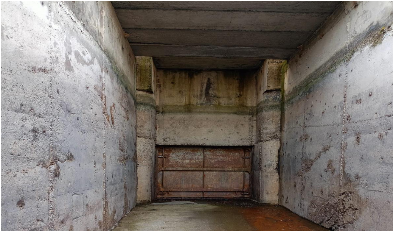
Затвор ремонтный плоский колесный №1 ШР ГЭС-3
