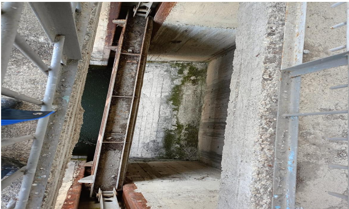
Затвор ремонтный плоский скользящий №2 НБ ГЭС-3
