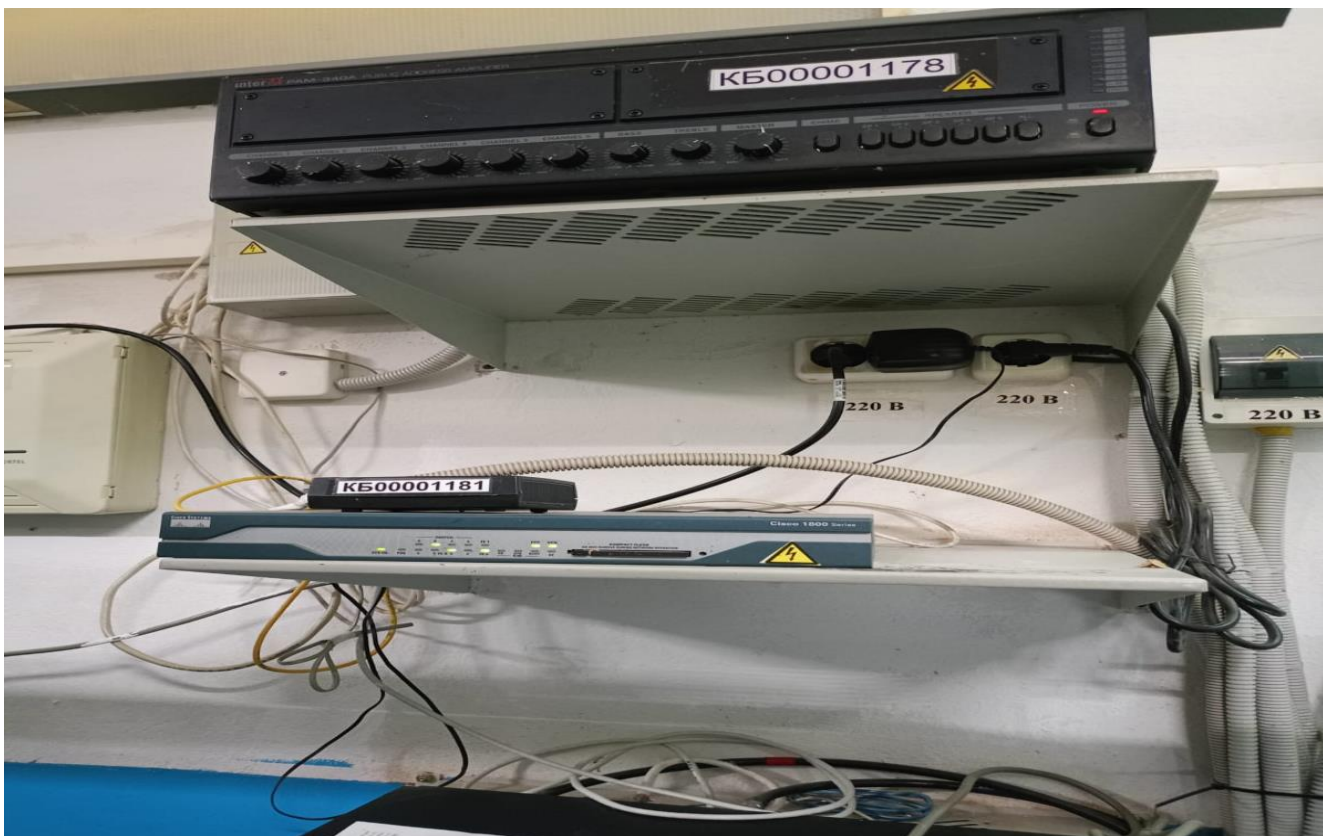
Аппаратура громкоговорящей поисковой связи (Система связи) ГЭС-3
