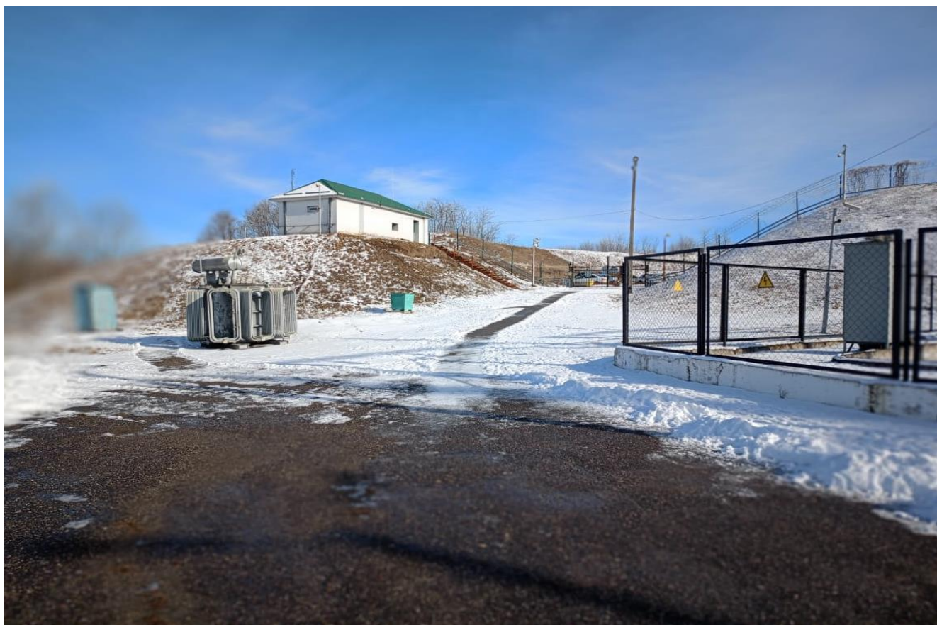
Автодороги и площадки ГЭС-3
