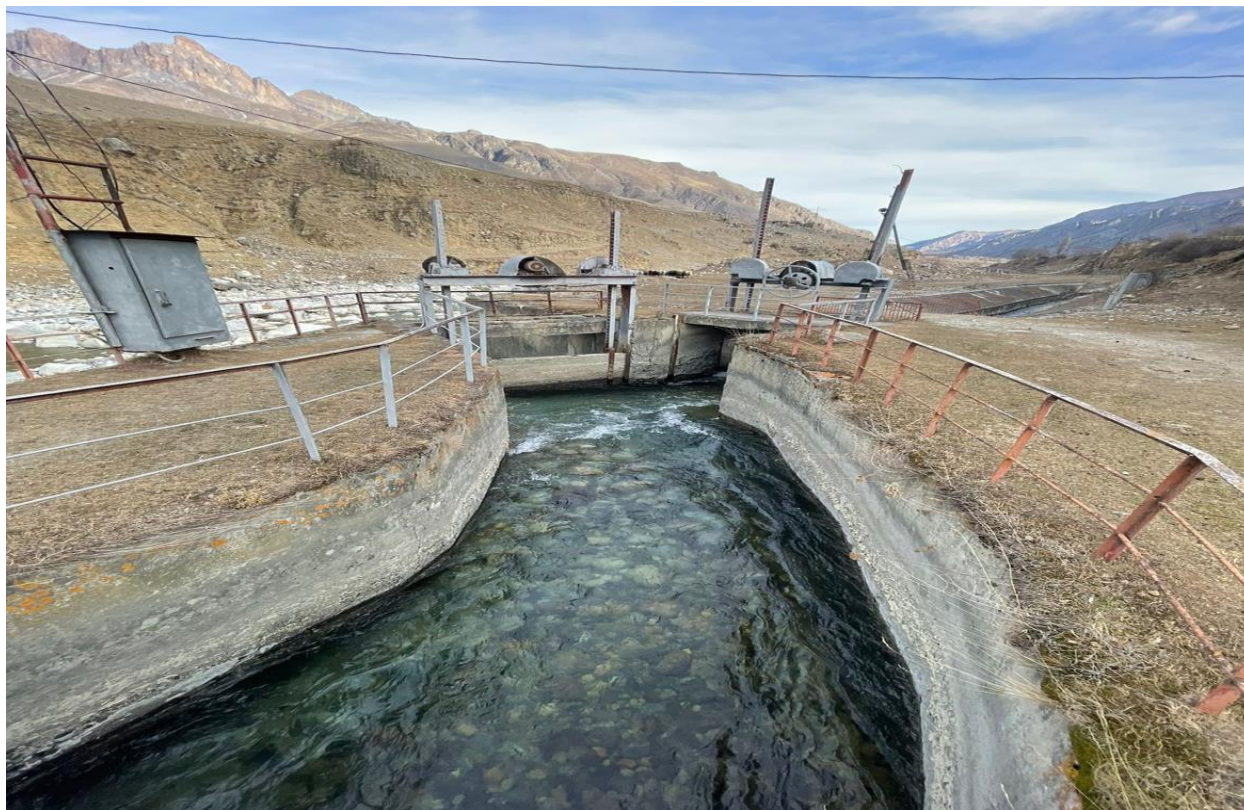
Шлюз-промывник пропускная способность 7м 3 /сек. МГЭС
