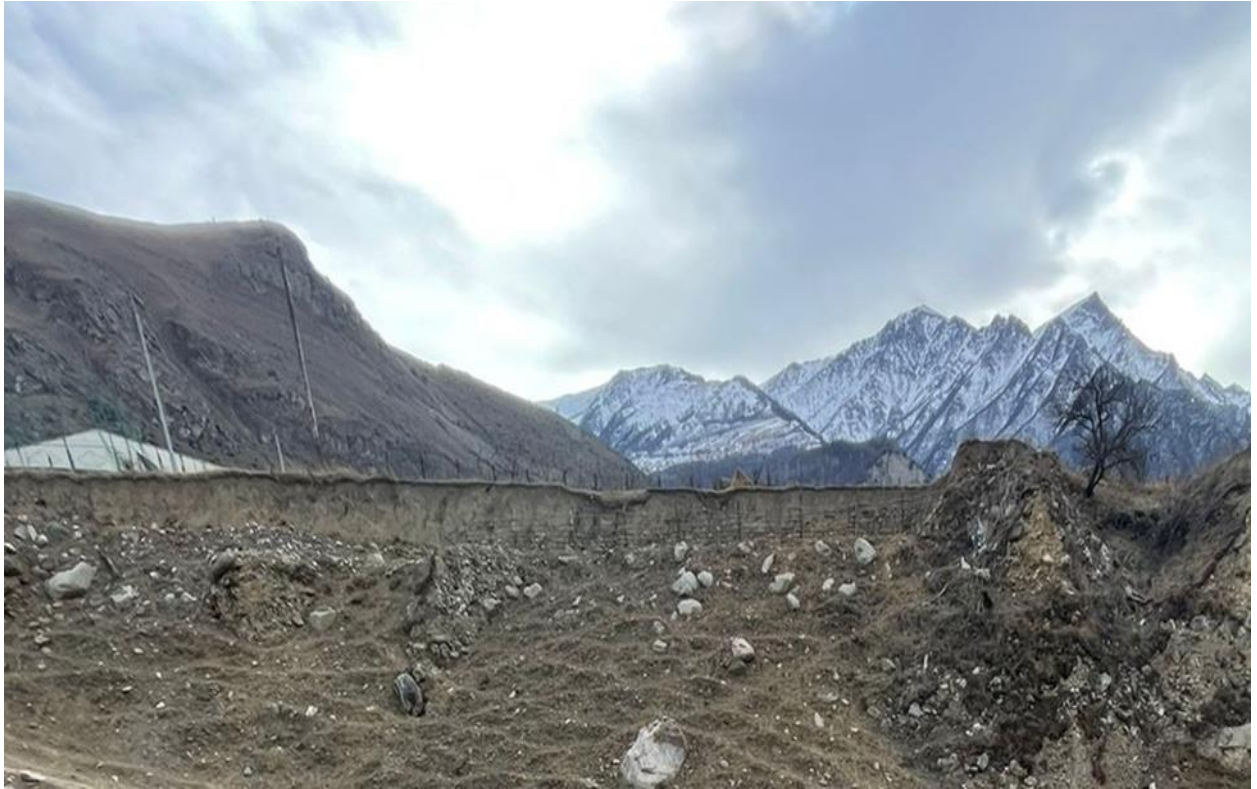
Водосливной канал МГЭС
