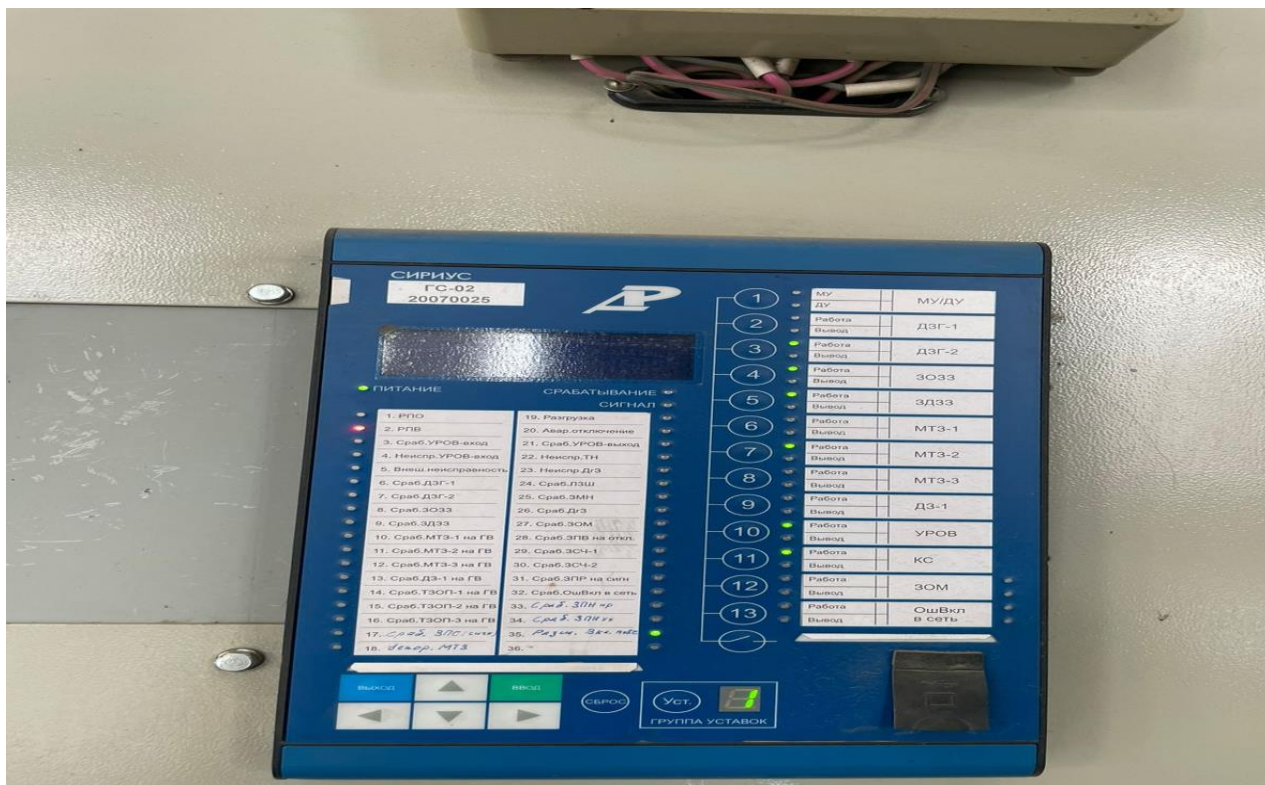
Устройство защиты микропроцессорное Сириус-2-МЛ-5А 220В-И1
