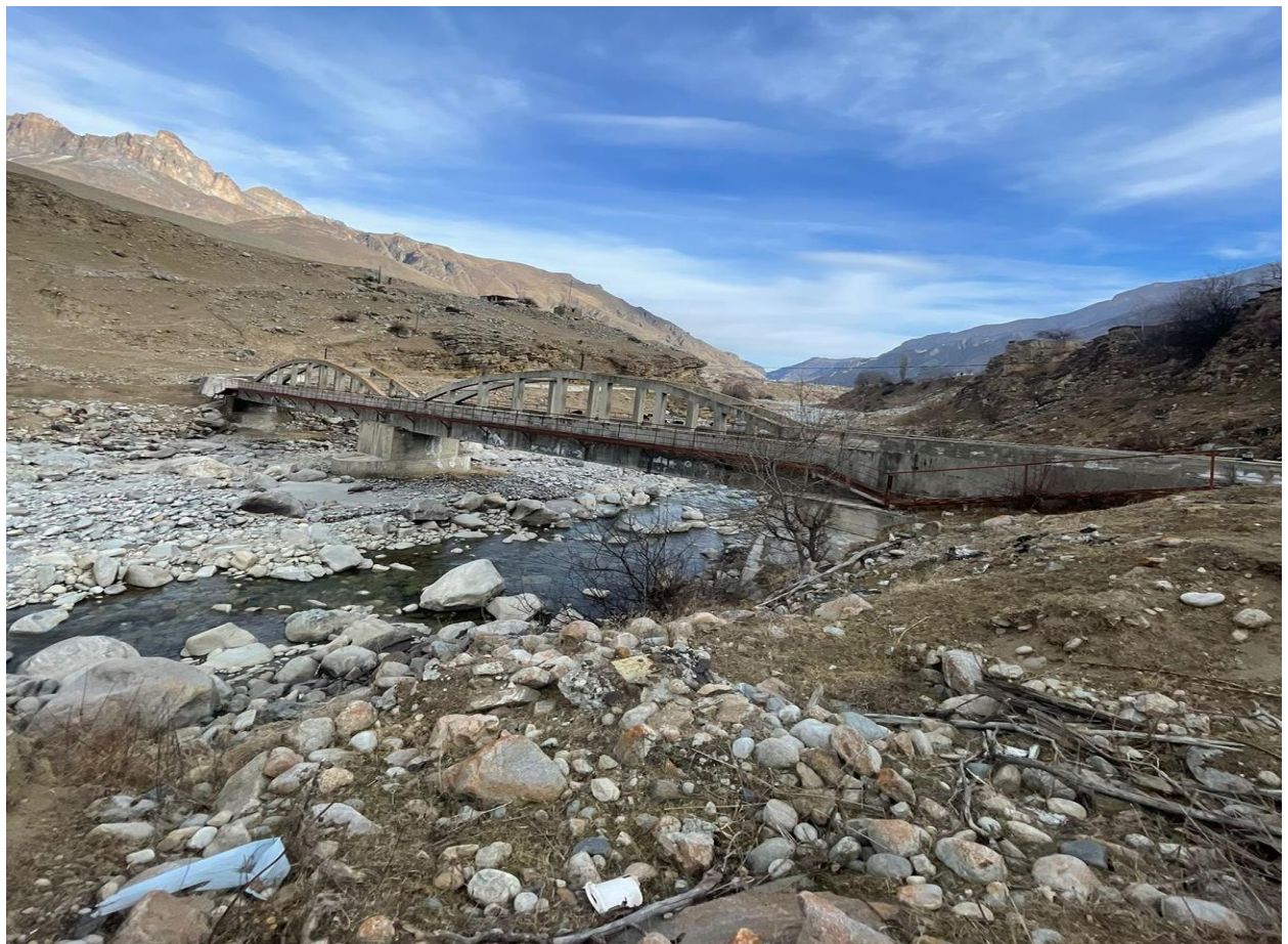
Акведук пропускная способность 35м 3 /сек.МГЭС
