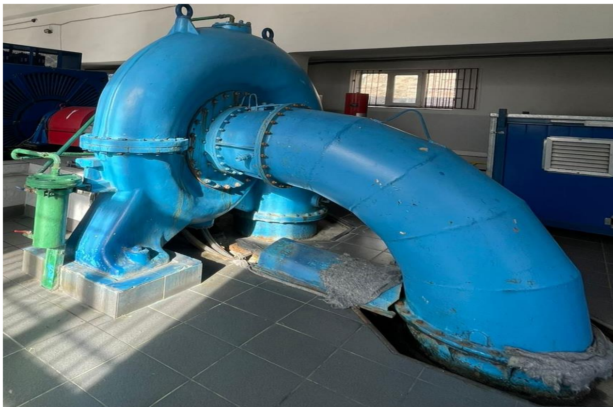
Гидротурбина РО 140-60 ст. ГА№1 МГЭС
