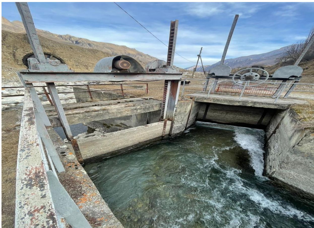
Затвор основной промывной галереи МГЭС
