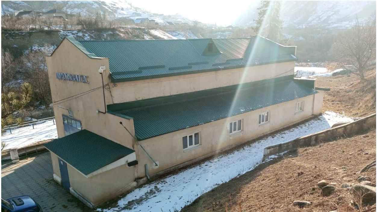
Здание надземной части ГЭС
