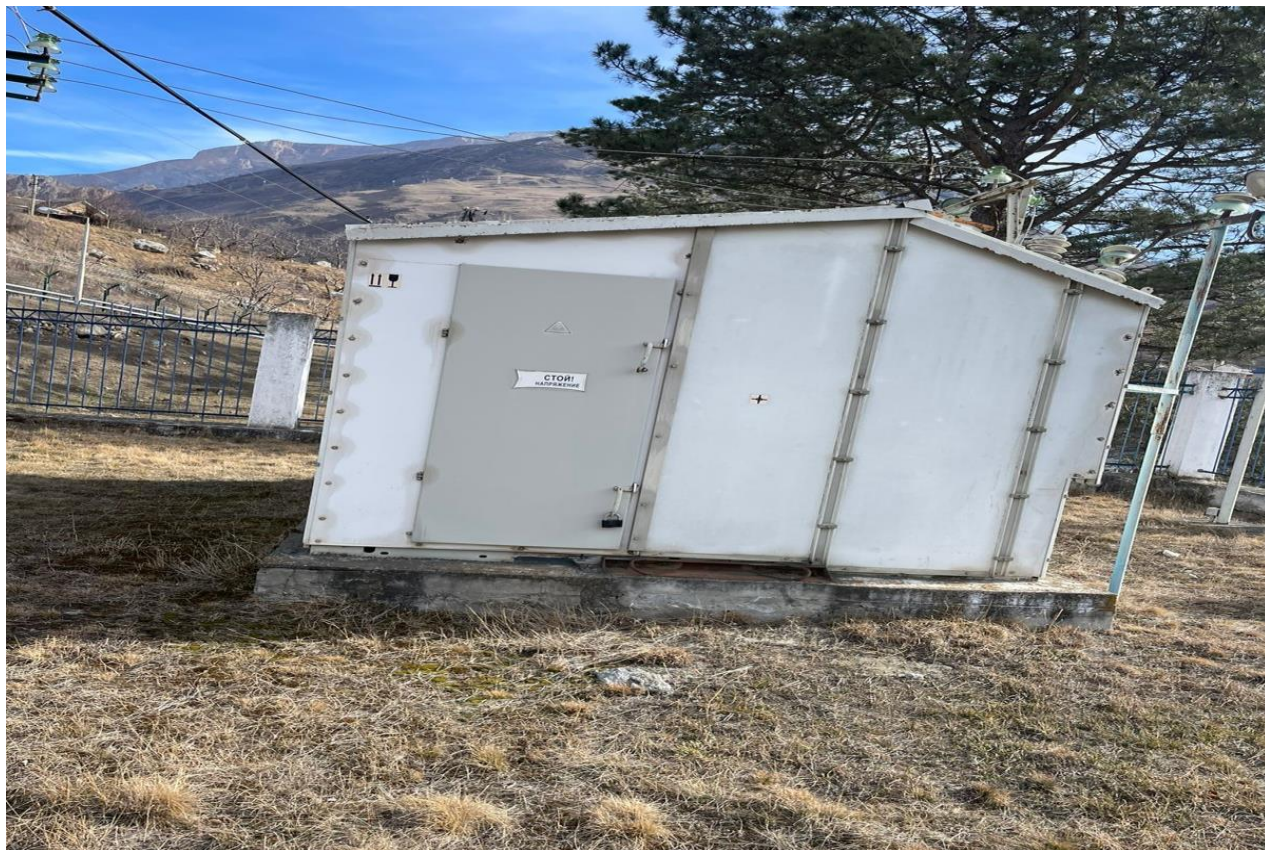
Комплектное распреустройство (10,5 кВ, 630А) серии К-59У1 МГЭС
