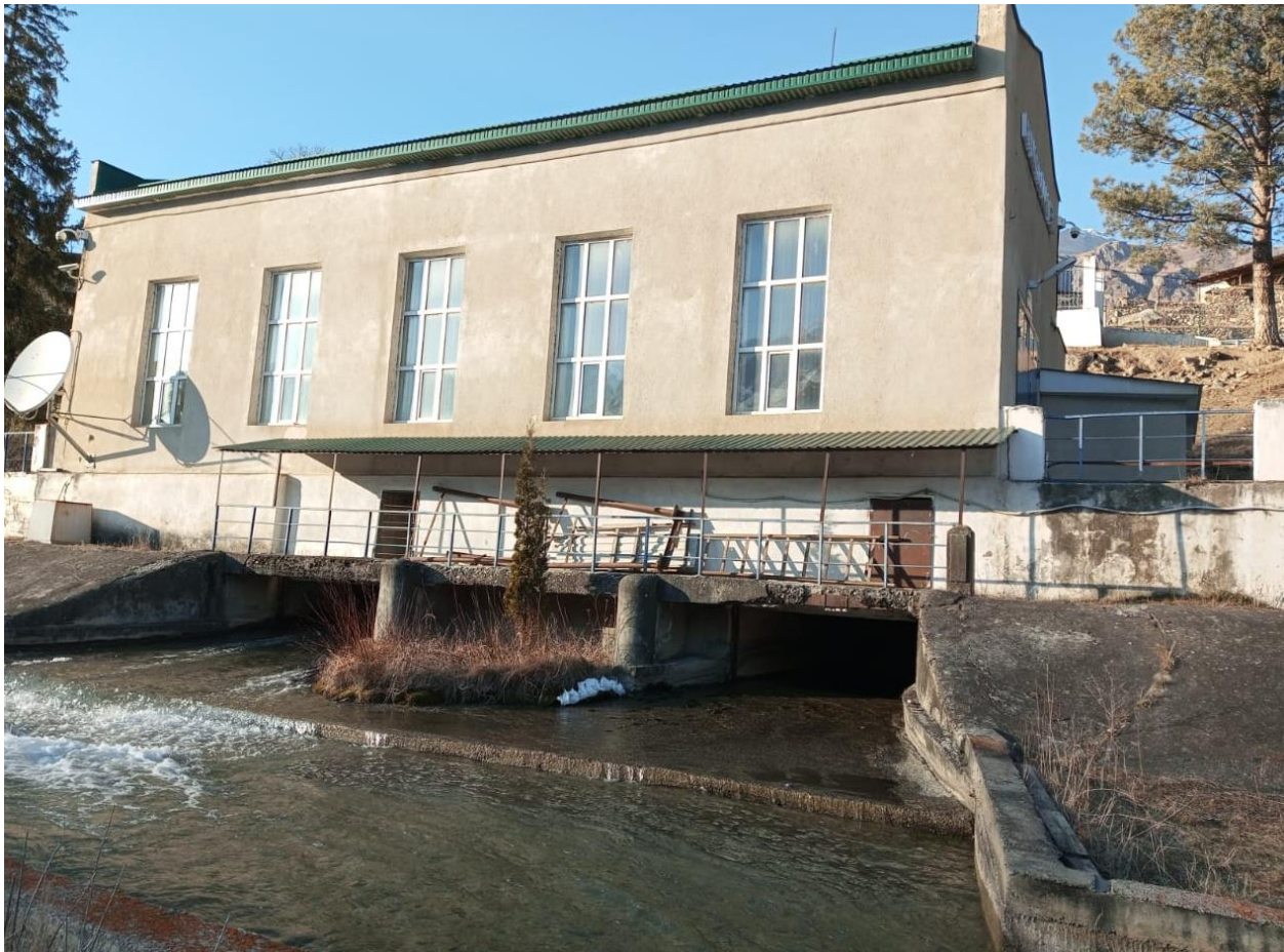
Здание надземной части ГЭС
