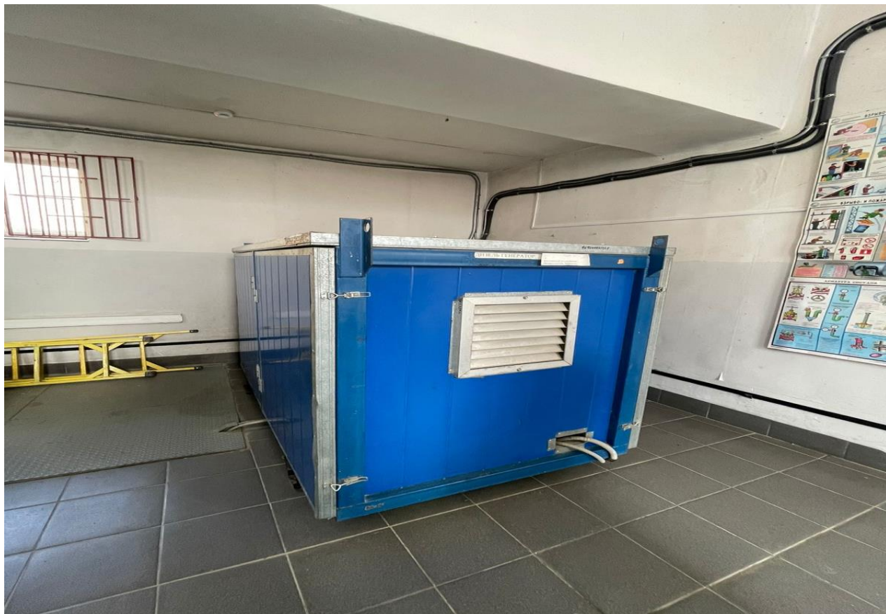
Дизельный генератор SDMO Pacific T 11.5 МГЭС
