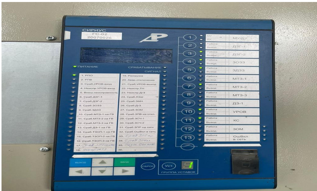
Устройство защиты микропроцессорное Сириус-2-МЛ-5А 220В-И1
