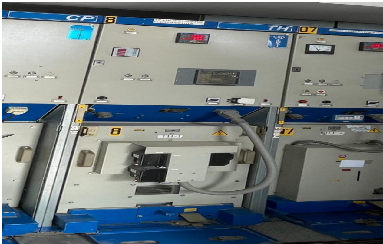
Трансформатор ТЛС 40/0, 4-Д/ун-11
