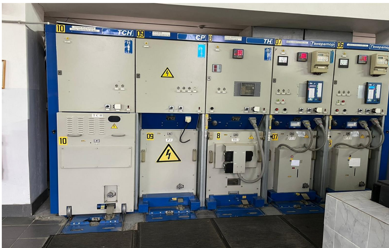
Комплектное распределительное устройство (10,5 кВ, 630А) серии К-63 МГЭС
