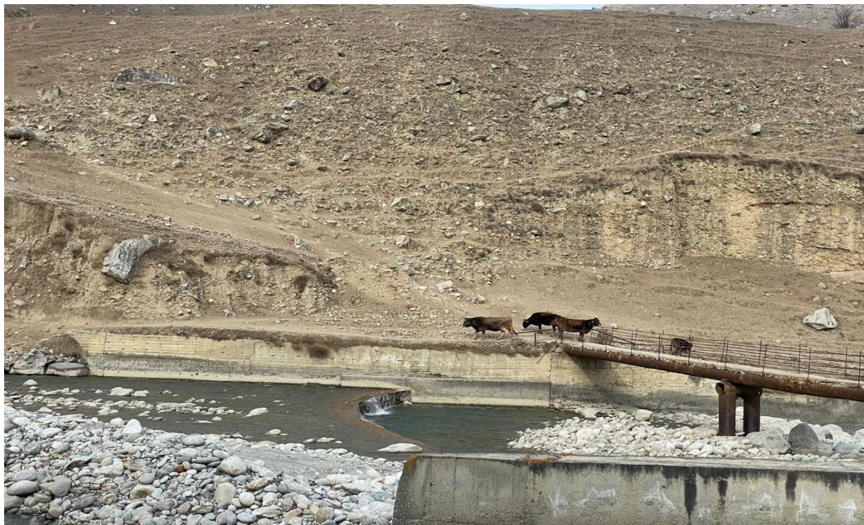
Стенка подпорная плотины Мухольской ГЭС
