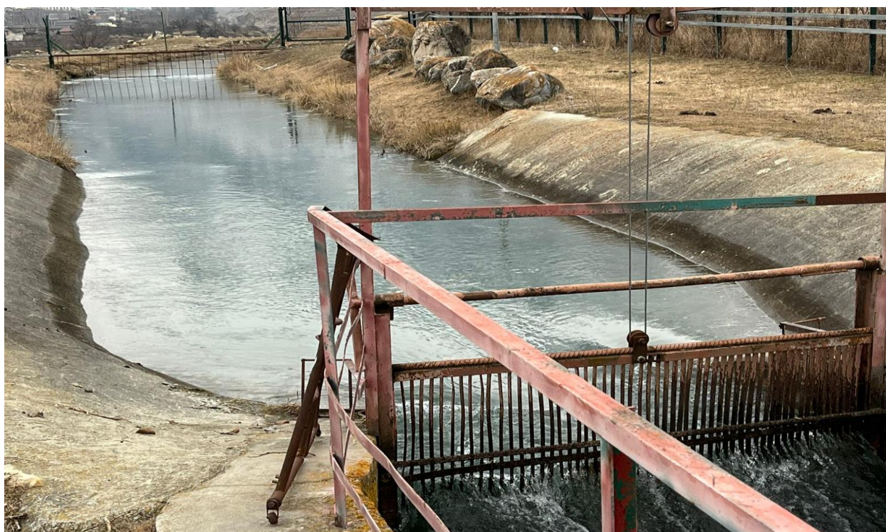
Напорный бассейн МГЭС
