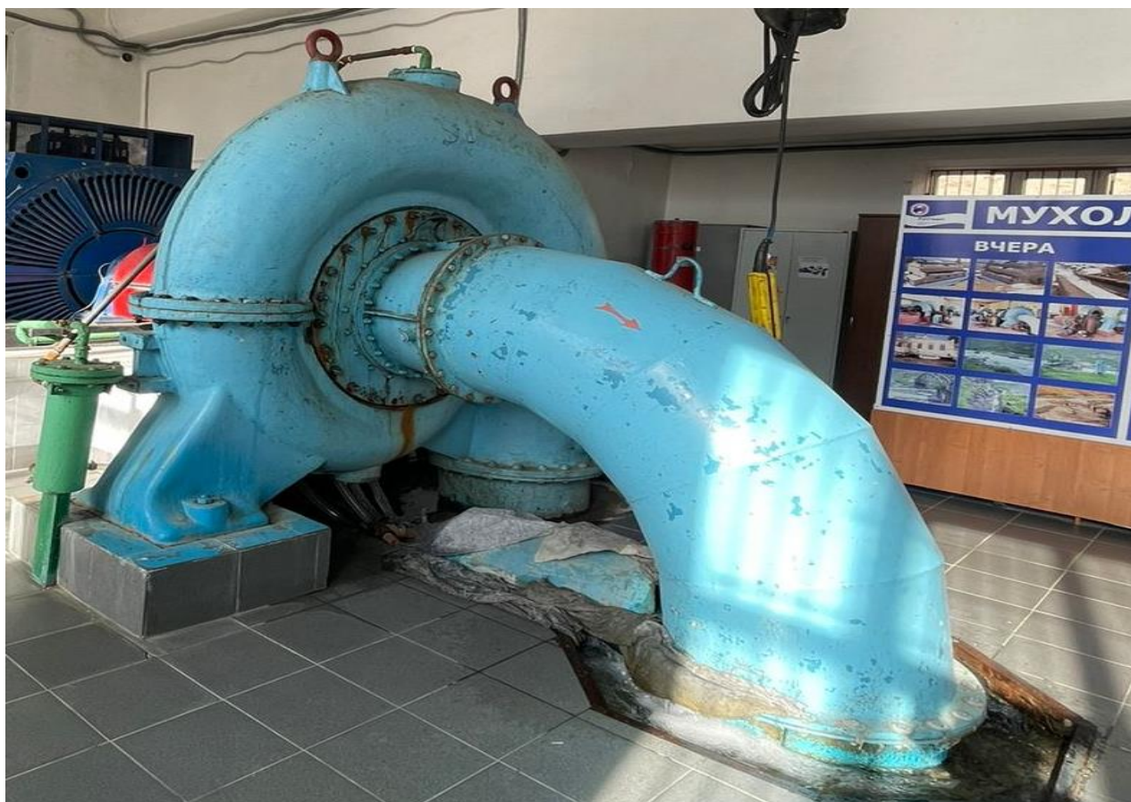
Гидротурбина РО 140-60 ст. ГА№2 МГЭС
