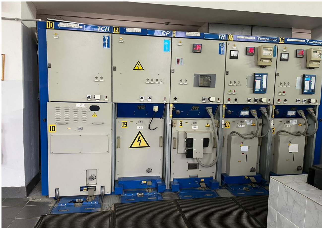
Комплектное распределительное устройство (10,5 кВ, 630А) серии К-59У1 МГЭС
