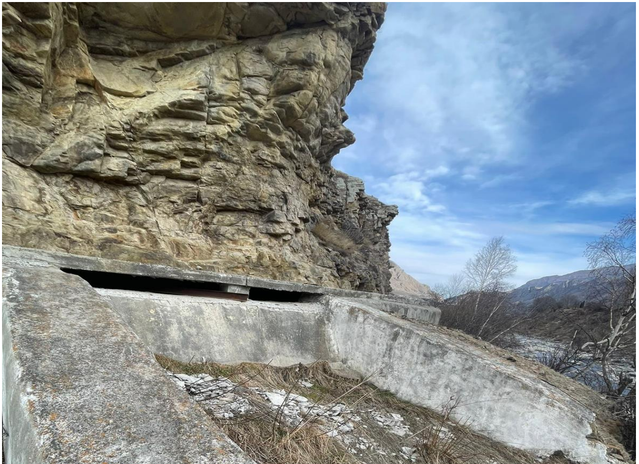
Водосливной канал МГЭС
