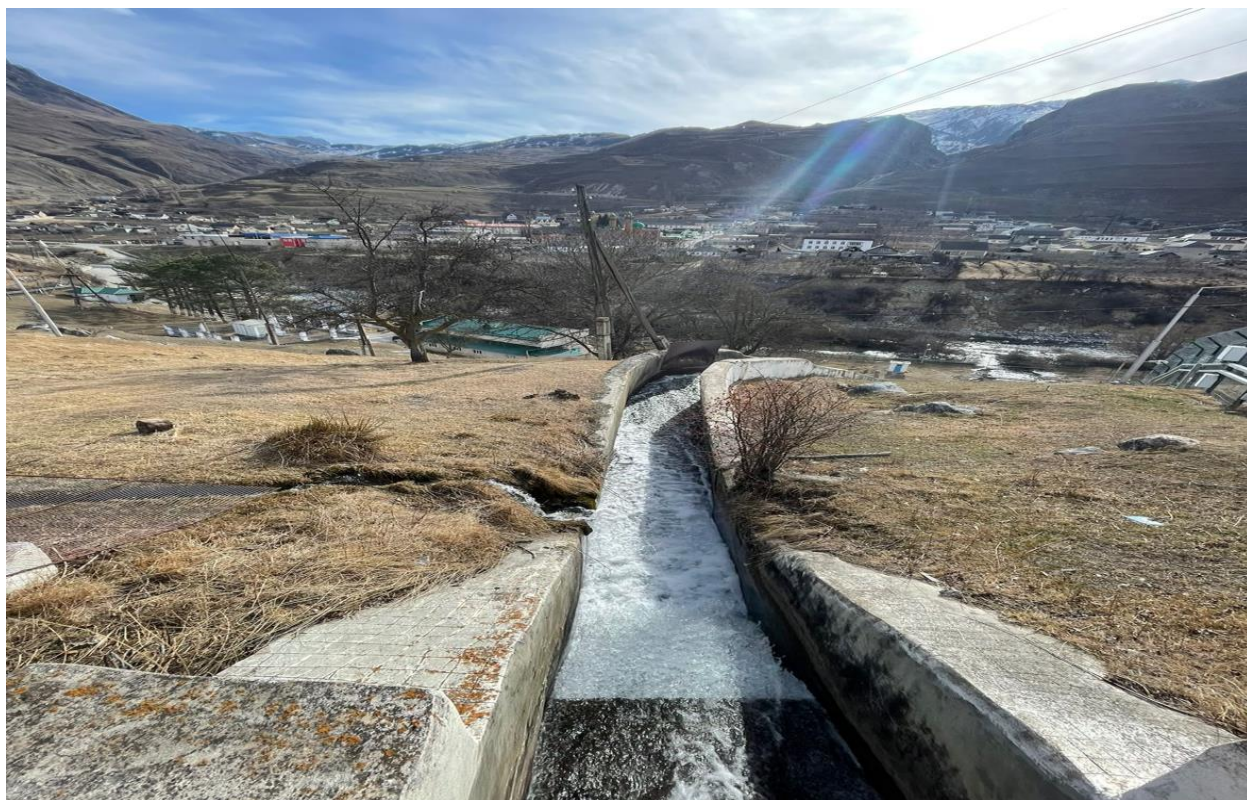
Холостой водосброс МГЭС
