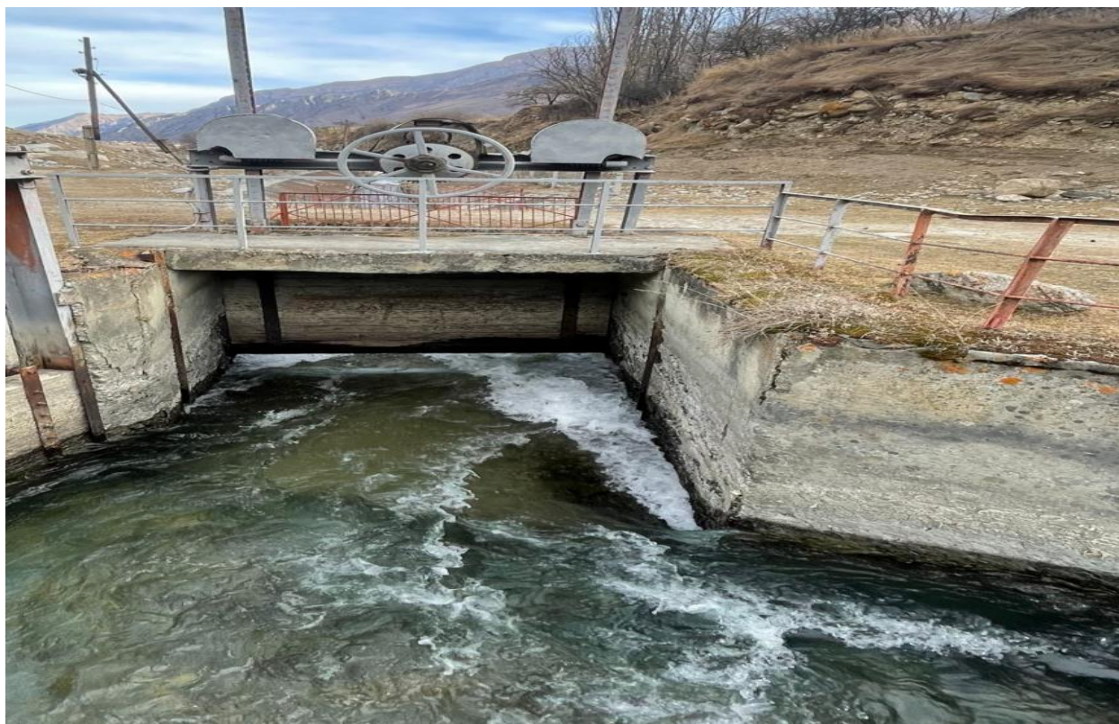
Затвор основной аванкамеры МГЭС
