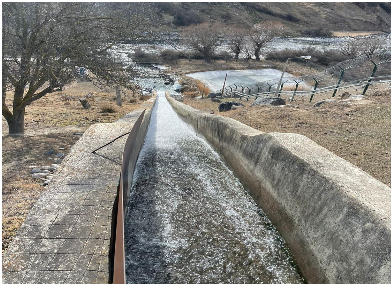
Холостой водосброс МГЭС
