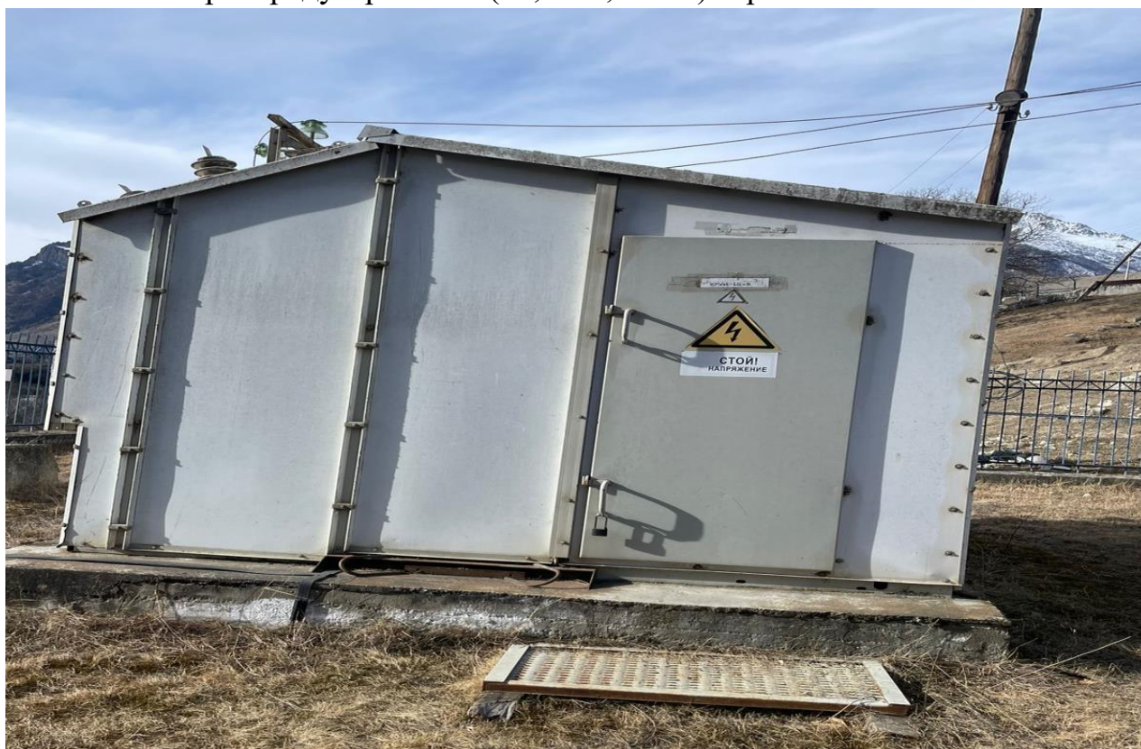
Комплектное распреустройство (10,5 кВ, 630А) серии К-59У1 МГЭС
