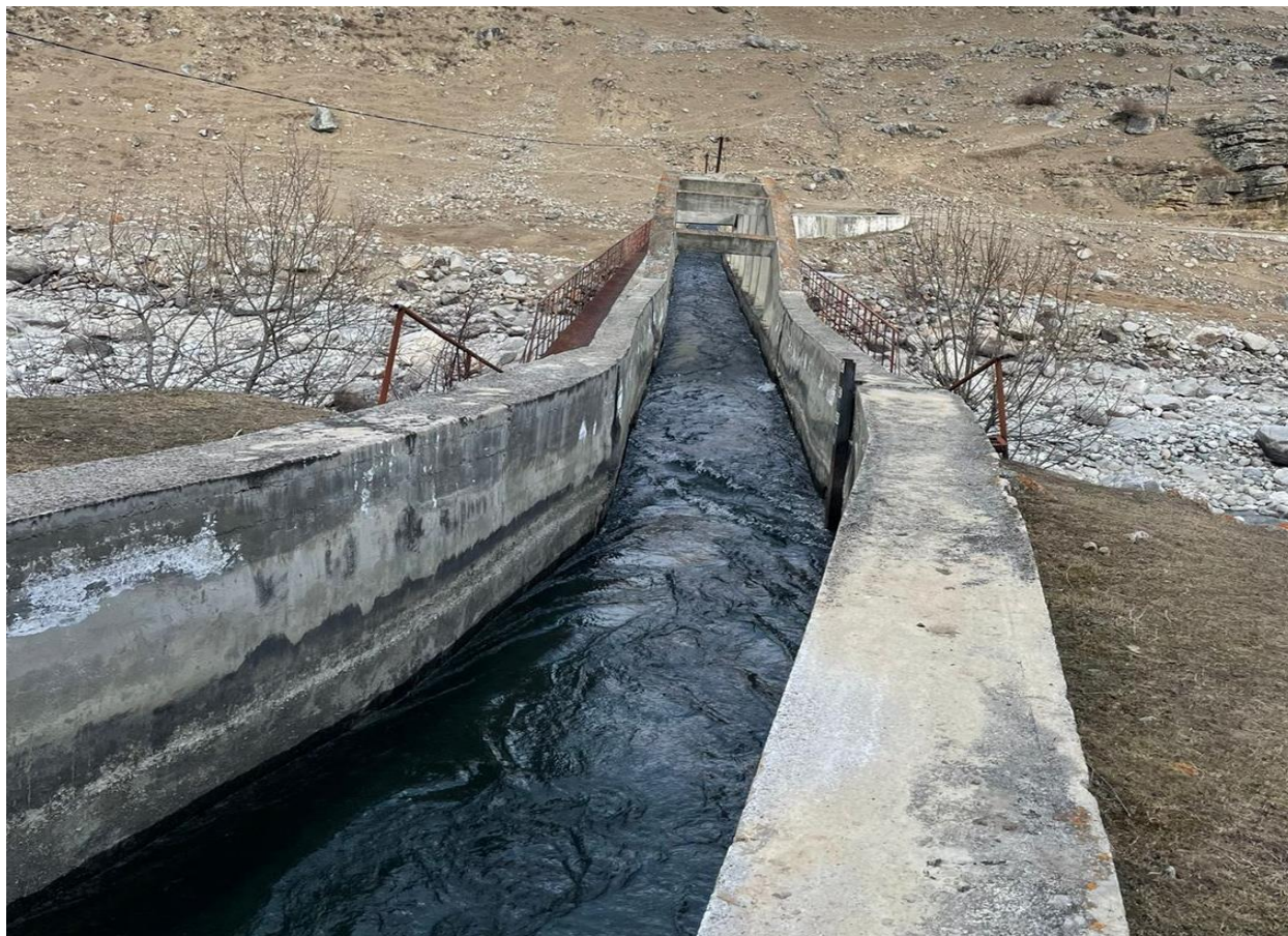
Акведук пропускная способность 35м 3 /сек.МГЭС
