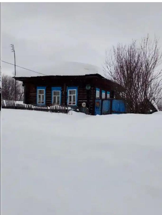
Фото №4. Общий вид дома
