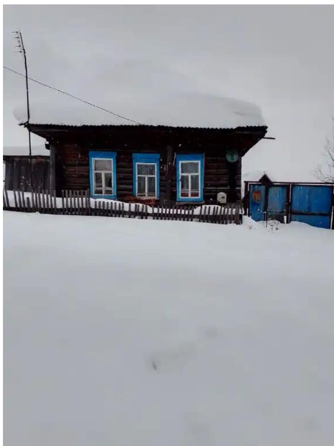
Фото №3. Общий вид дома
