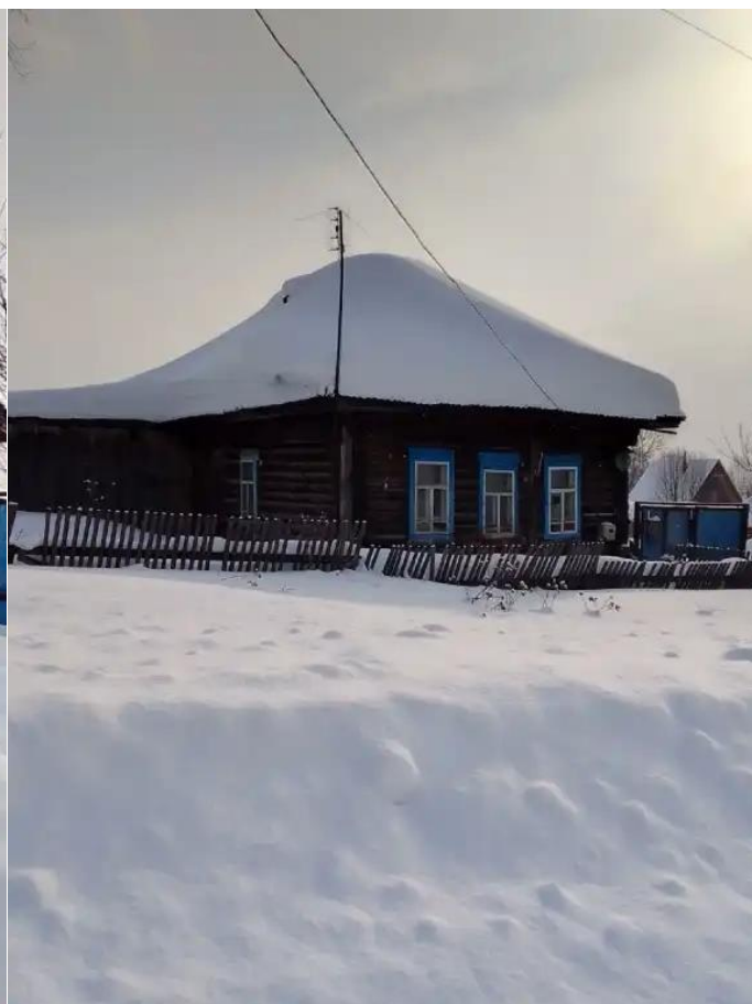
Фото №2. Общий вид дома
