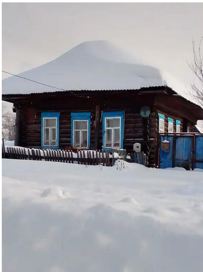
Фото №1. Общий вид дома
