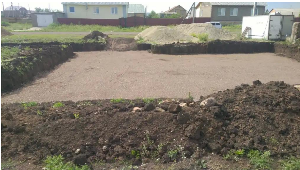
Фото №1. Общий вид участка
