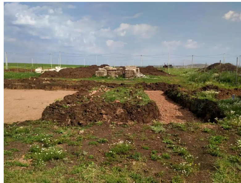
Фото №2. Общий вид участка
