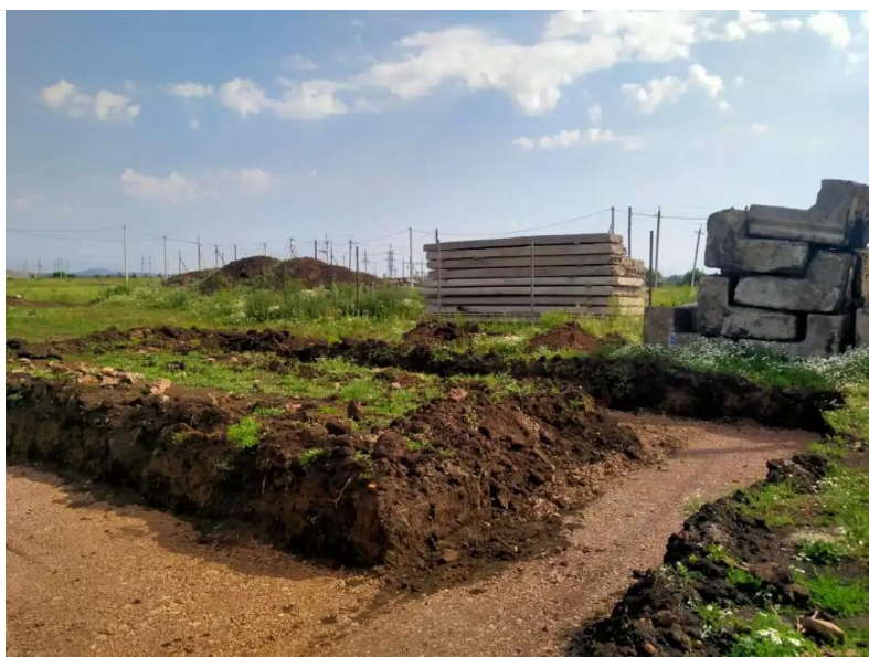
Фото №3. Общий вид участка
