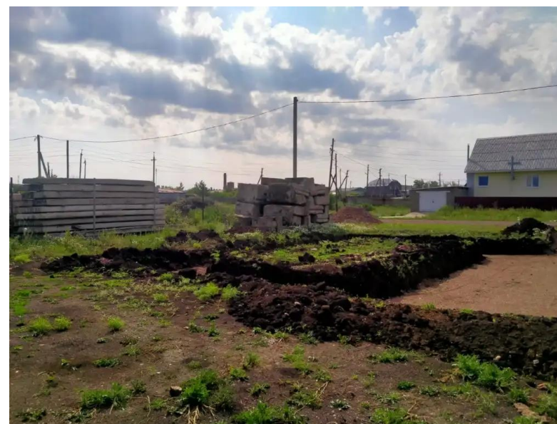
Фото №4. Общий вид участка
