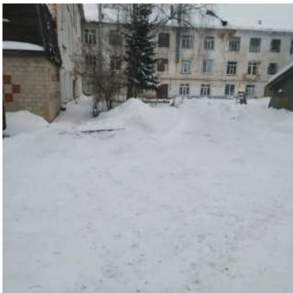
Фото №1. Общий вид дома
