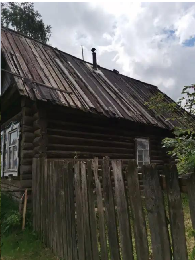
Фото №8. Общий вид дома
