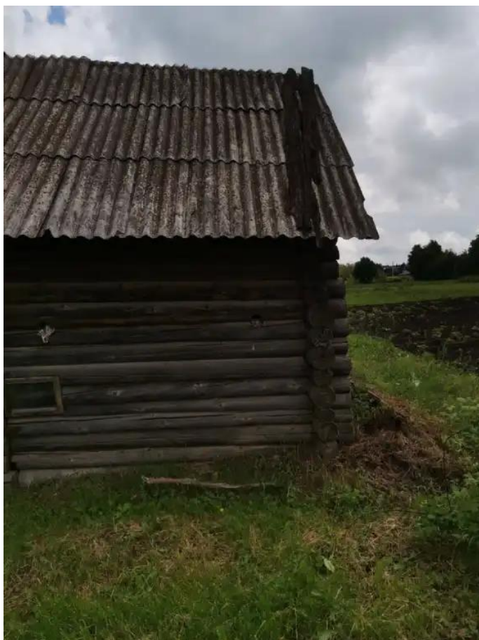
Фото №7. Общий вид дома
