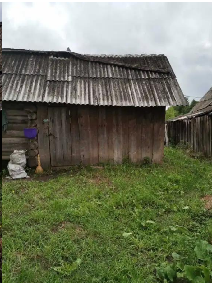
Фото №4. Общий вид дома
