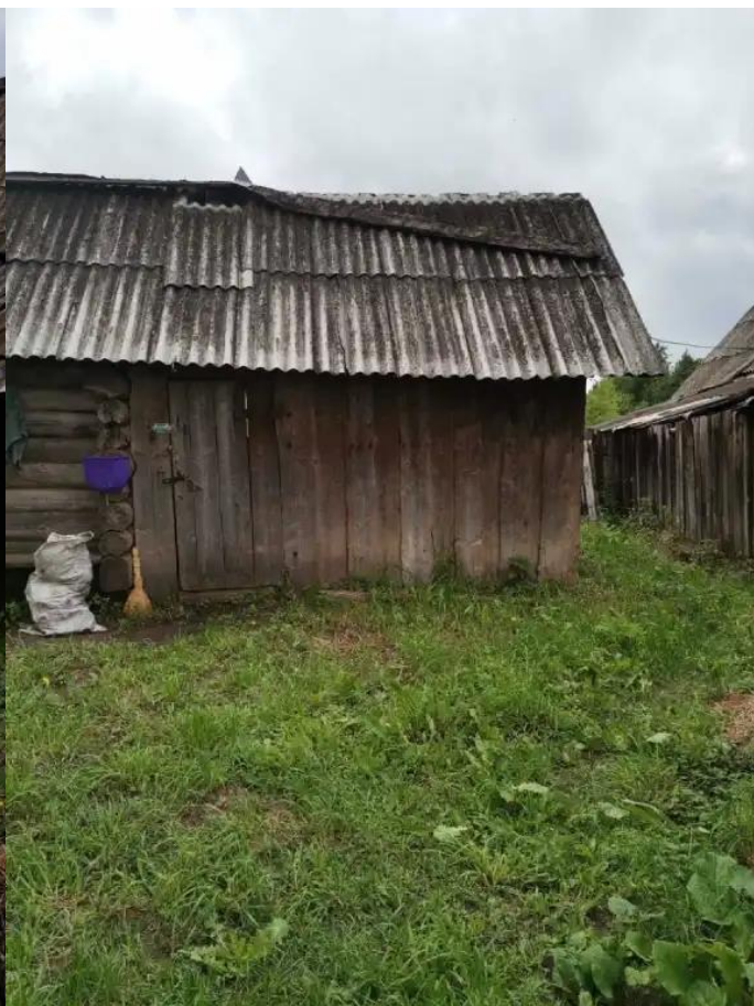
Фото №6. Общий вид дома
