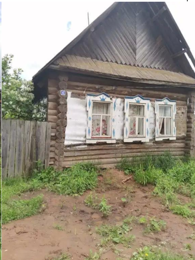
Фото №2. Общий вид дома
