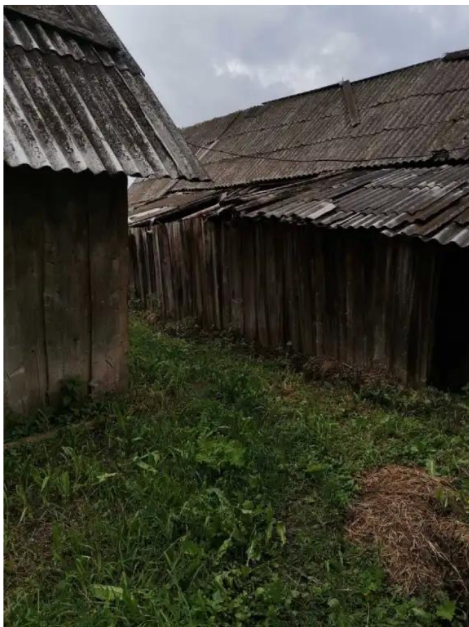
Фото №3. Общий вид дома
