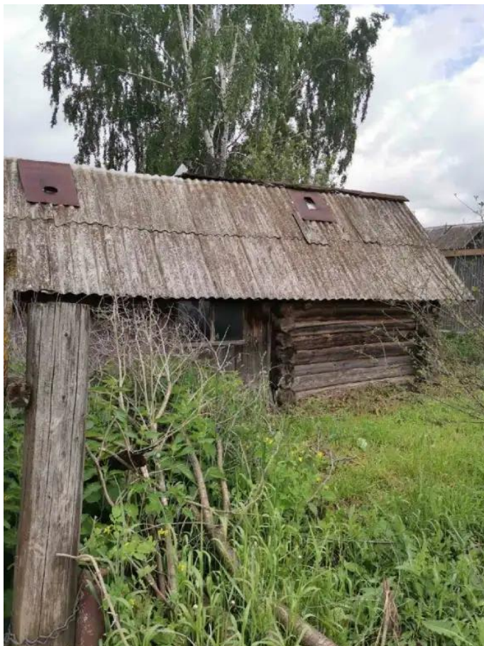
Фото №1. Общий вид дома
