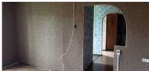
Фото 6. Внутренние помещения квартиры
