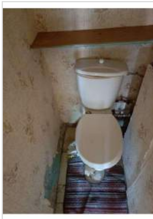
Фото 2. Туалет (помещение №2 по плану БТИ)
