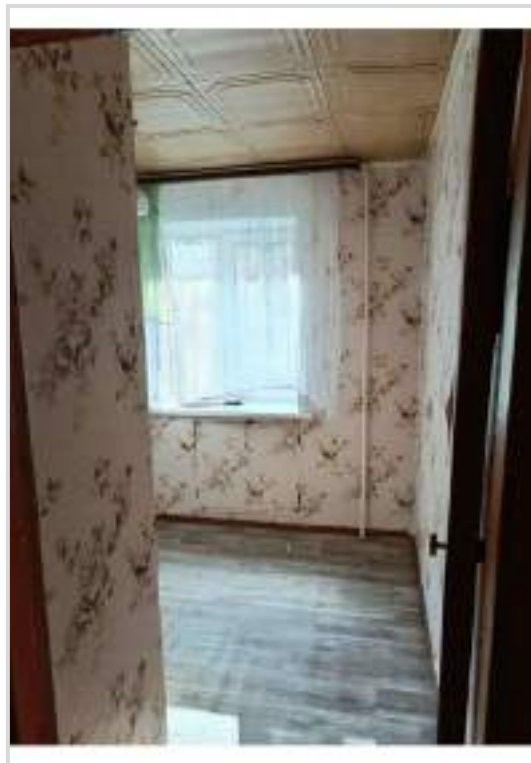
Фото 16. Кухня (помещение №4 по плану БТИ)
