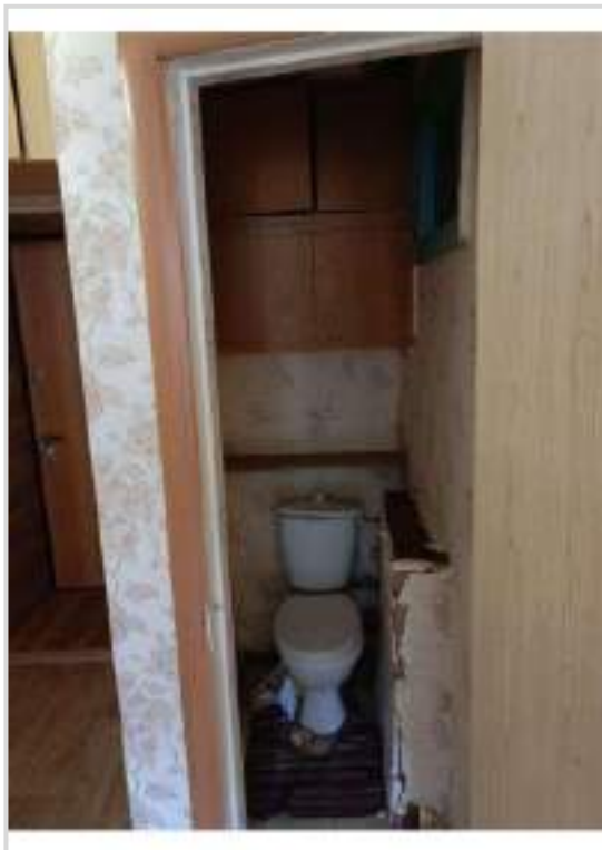
Фото 1. Туалет (помещение №2 по плану БТИ)
