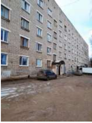
Фото №17. Общий вид дома и придомовая территория
