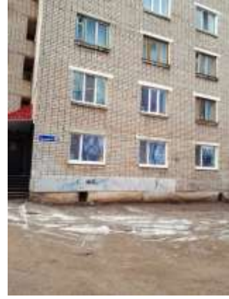
Фото №18. Общий вид дома и придомовая территория
