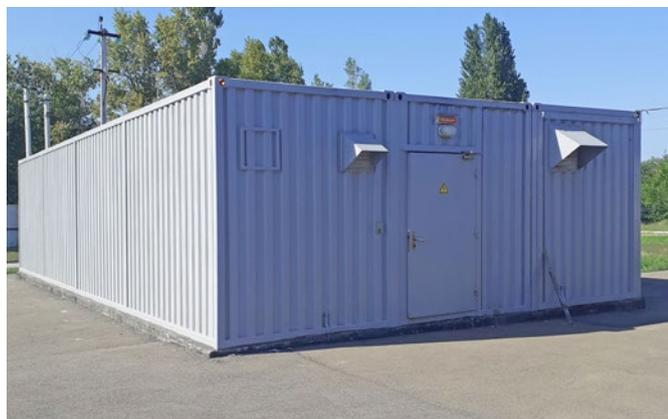
Газопоршневая теплоэлектростанция предназначена для постоянного или резервного электроснабжения объектов различного назначения.
