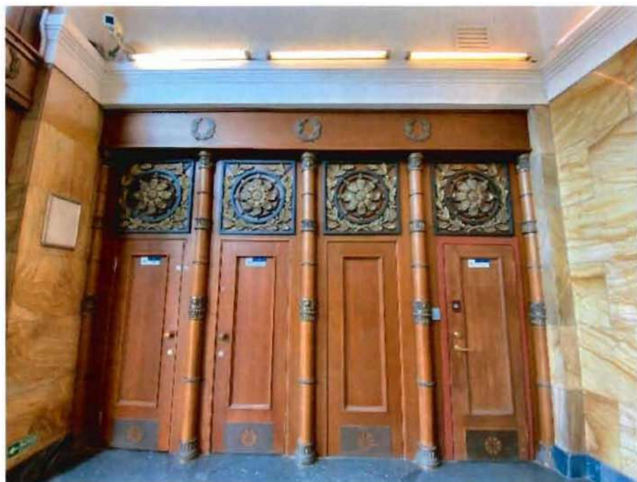
8. Помещение вестибюля объекта культурного наследия. Фото от 12.05.2022.
