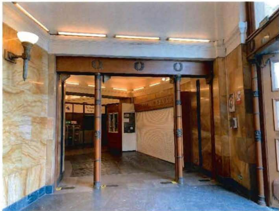
7. Помещение вестибюля объекта культурного наследия. Фото от 12.05.2022.
