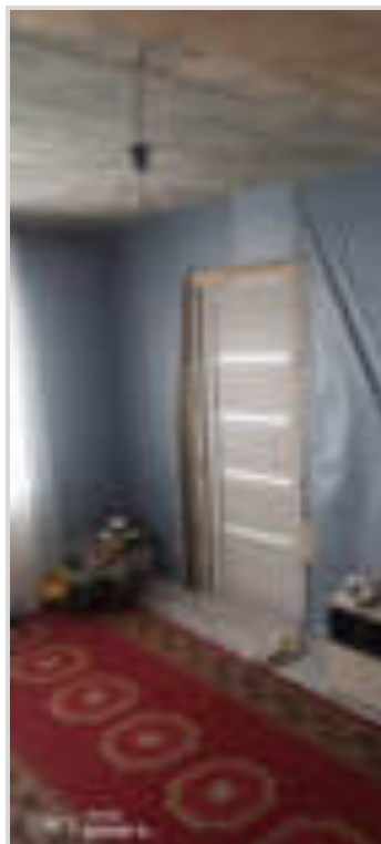
Фото 4. Жилая (помещение №2 по плану БТИ)
