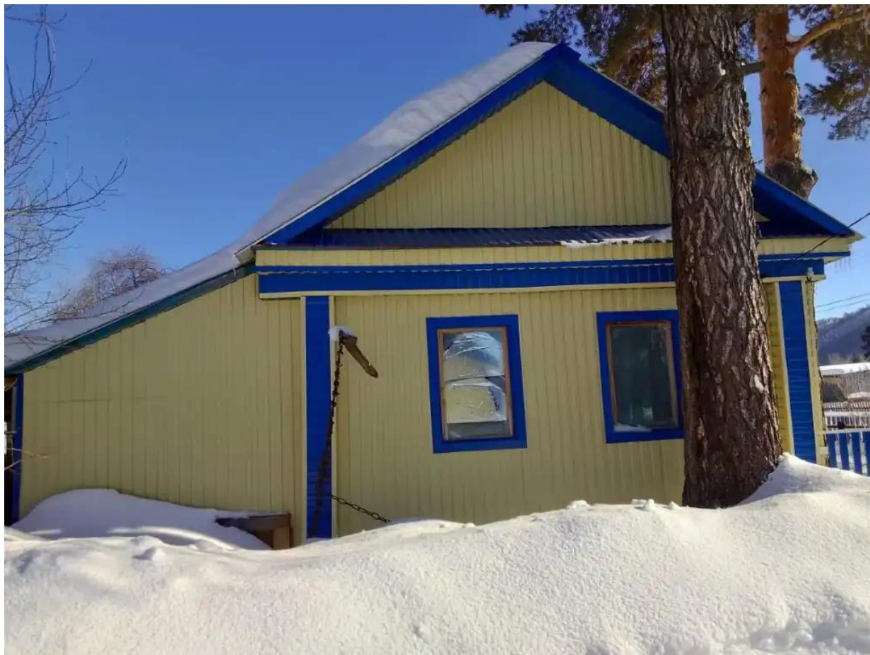
Фото №1. Общий вид дома
