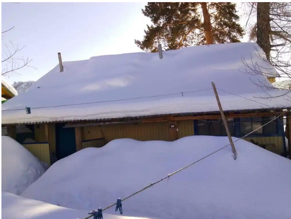
Фото №2. Общий вид дома
