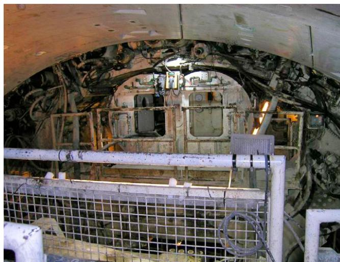
Головная часть ТПМК состоит из ротора с режущим инструментом для разработки грунта, соединённым с гидравлическим приводом мощностью 2 800 кВт, оболочки, под прикрытием которой при помощи блокоукладчика с вакуумным захватом происходит сооружение обделки тоннеля.
