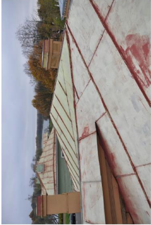
Фото 1. Отслоение красочного слоя местами. Молниезащита. Следы коррозии металла.
