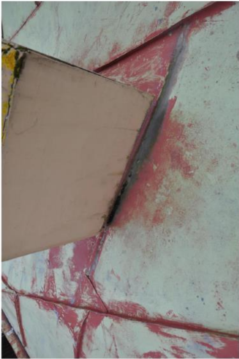
Фото 16. Отслоение красочного слоя кровли. Следы коррозии металла (очаг ржавчины).
