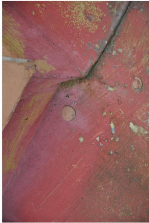
Фото 9. Разгерметизация лежащего и стоячего фальцев. Отслоение красочного слоя окрытия кровли.
