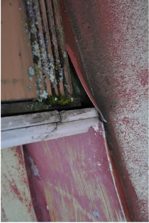
Фото 2. Следы коррозии металла (очаг ржавчины). Следы биопоражения.
