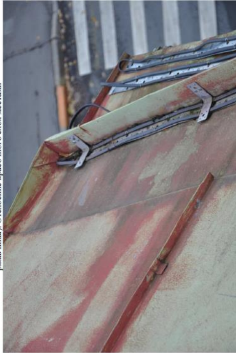
Фото 3. Конструкция системы подотрева карнизных свесов. Следы коррозии металла (очаги ржавчины). Отслоение красочного слоя местами
