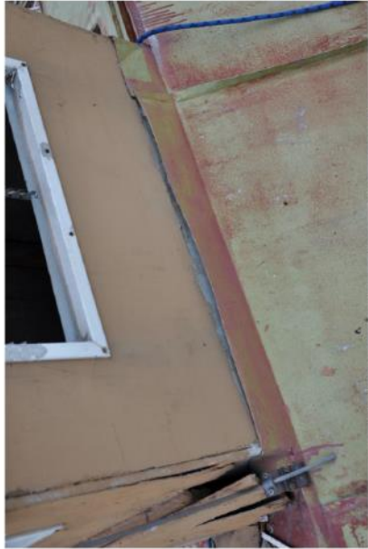
Фото 15. Нарушение примыкания кровли к трубе.
