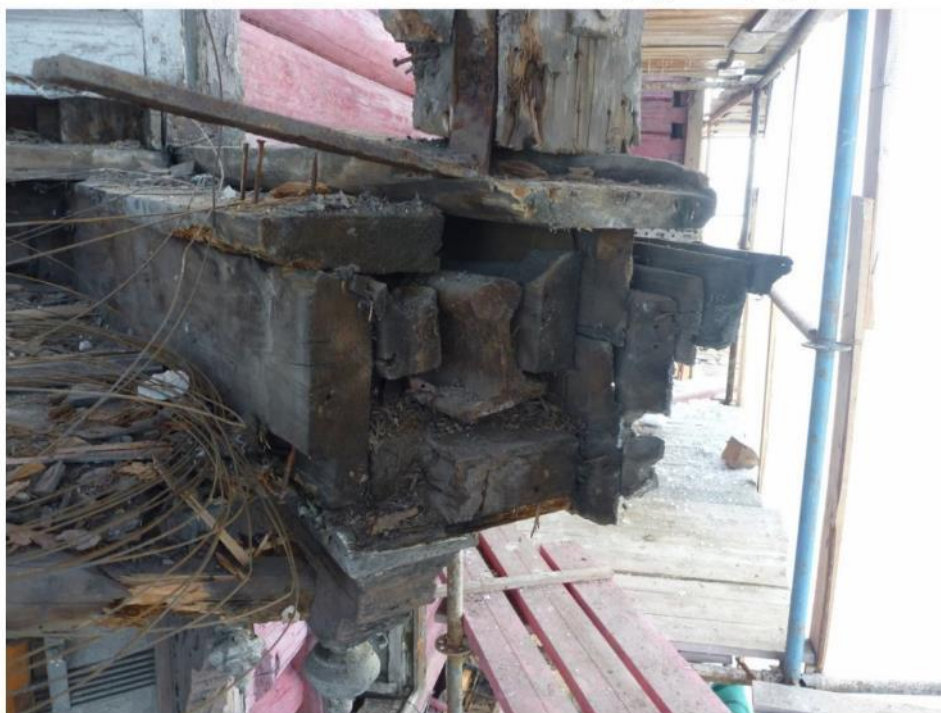
Фото 2. Разборка балкона здания по Санкт-Петербургскому пр., д.40/16
