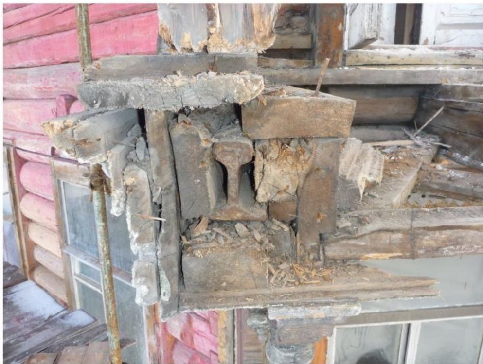
Фото 4. Разборка балкона здания по Санкт-Петербургскому пр., д.40/16
