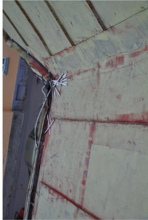
Фото 3. Конструкция системы подотрева карнизных свесов. Следы коррозии металла (очаги ржавчины). Отслоение красочного слоя местами
