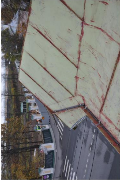
Фото 7. Конструкция системы подогрева карнизных свесов. Следы коррозии металла (очаг ржавчины). Отслоение красочного слоя окрытия кровли.
