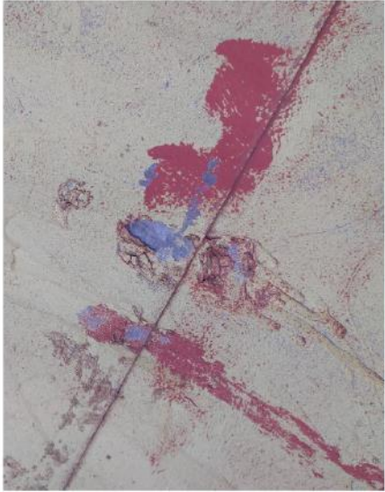
Фото 14. Отслоение красочного слоя кровли.
