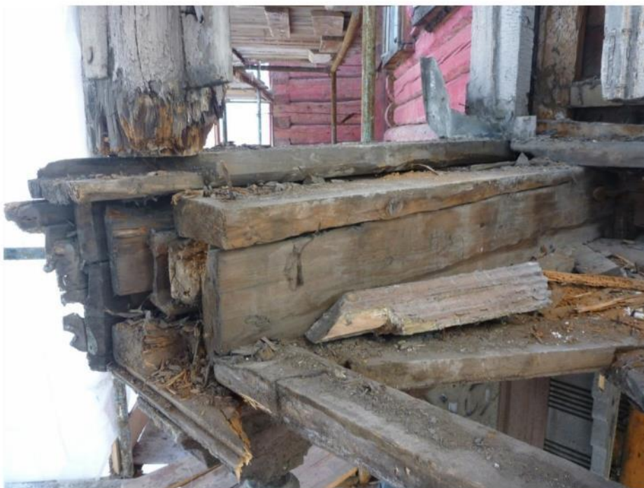
Фото 1. Разборка балкона здания по Санкт-Петербургскому пр., д.40/16
