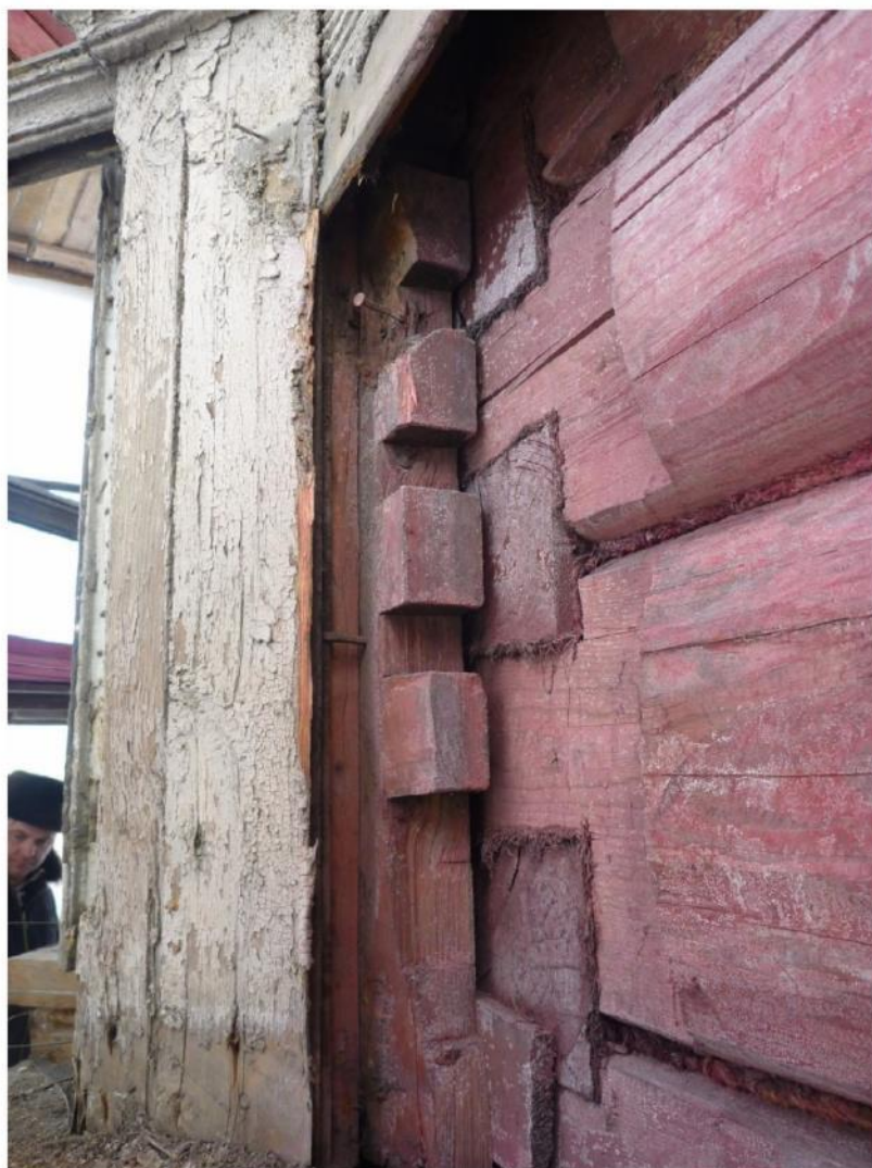
Фото 9. Разборка обшивки здания по Санкт-Петербургскому пр., д.40/16
