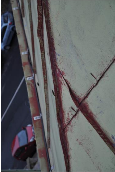
Фото 8. Разгерметизация лежачего и стоячего фальцев. Отслоение красочного слоя окрытия кровли.
