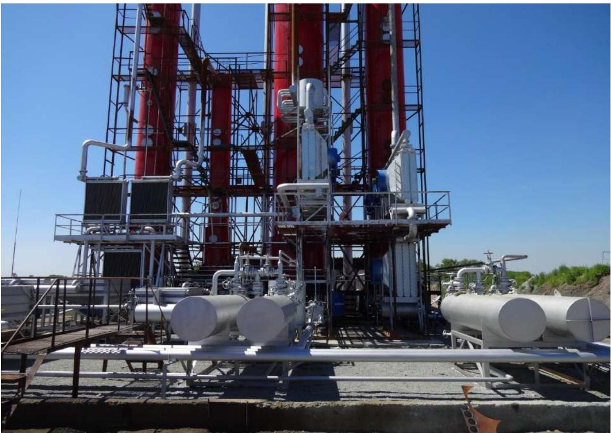
Вид на блок колонн, теплообменников, охладителей в процессе монтажа.
